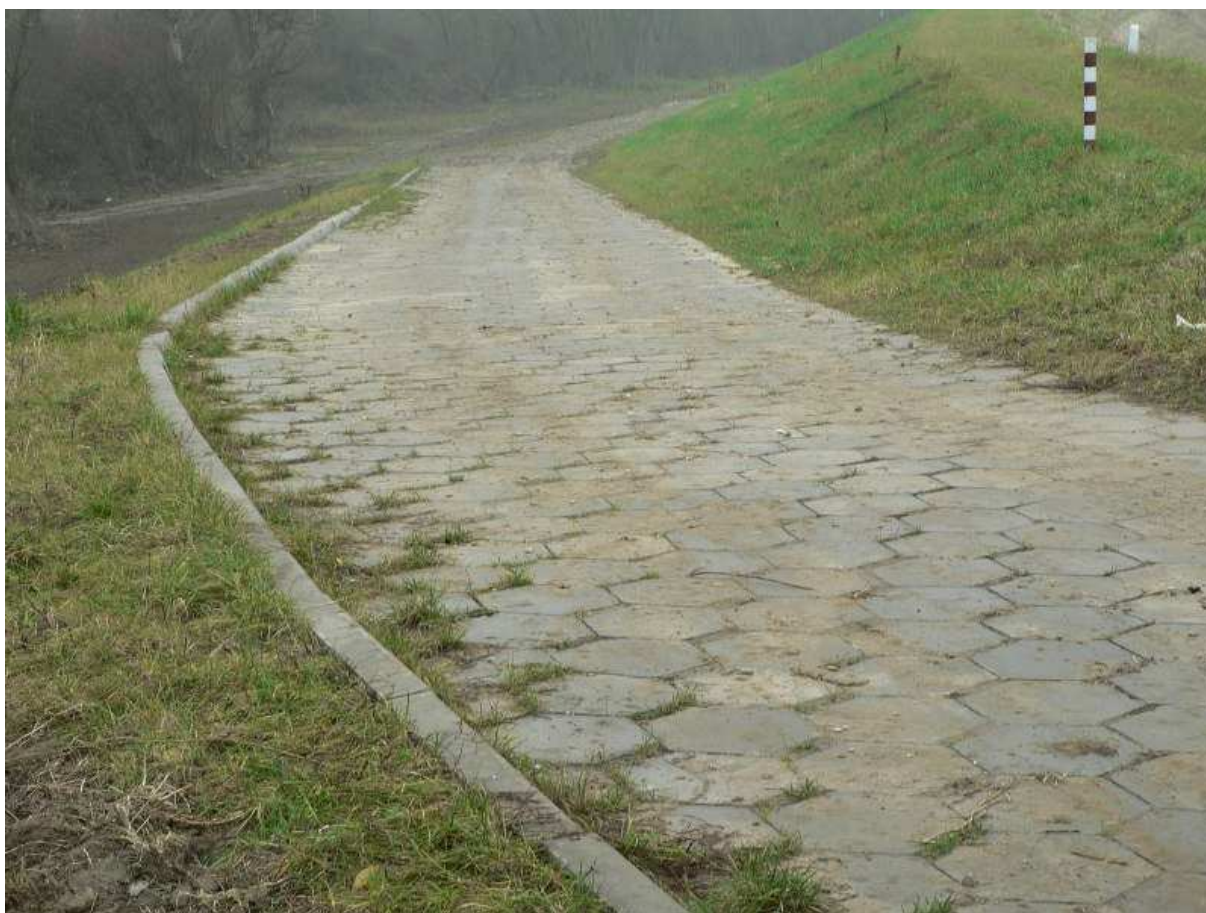
Fot. 2 Rampa wałowa – Tarnowce – Słupiec.
