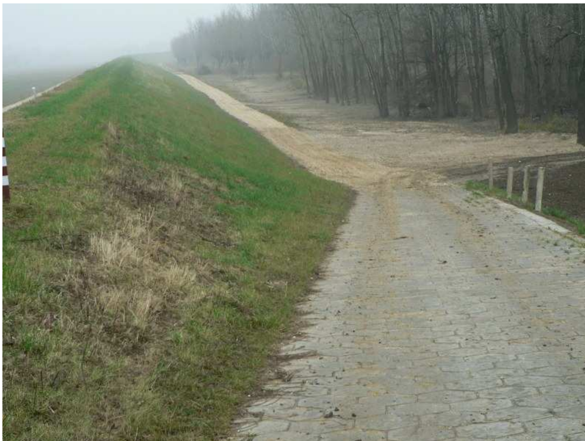
Fot. 11 Korpus wału z fragmentem rampy przejazdowej.- Tarnowce – Słupiec.
