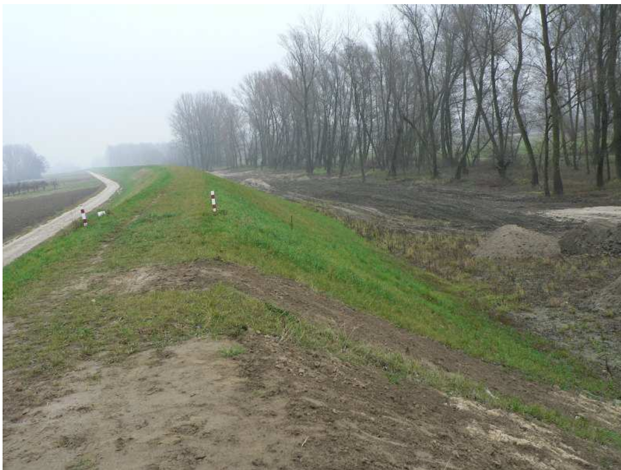
Fot.16 Korpus wału z drogą przywałową. – Niekurza – Matiaszów.
