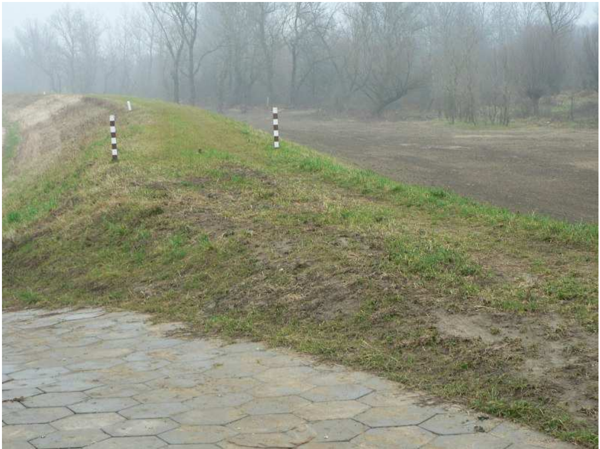
Fot. 1 Korpus wału z rogatkami i fragmentem rampy wałowej - Tarnowce – Słupiec.
