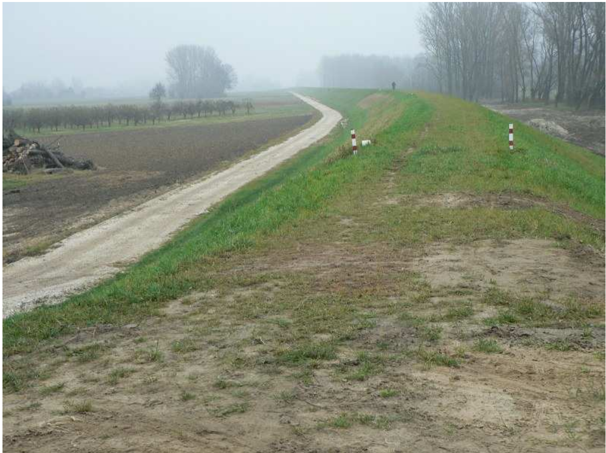
Fot. 18 Droga powodziowa na ławce przywałowej. – Niekurza - Matiaszów
