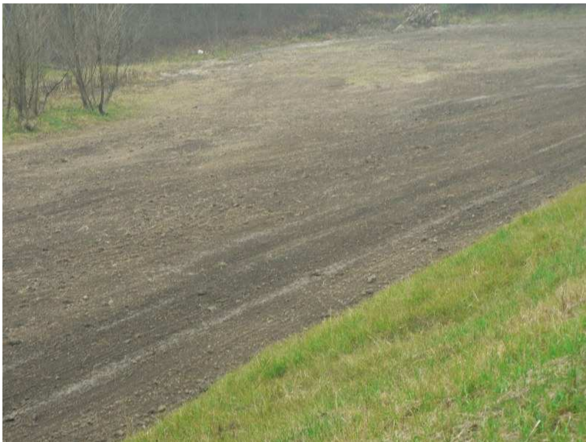
Fot. 9 Odbudowane międzywale przy stopie wału, rekultywacja terenu. – Tarnowce – Słupiec.
