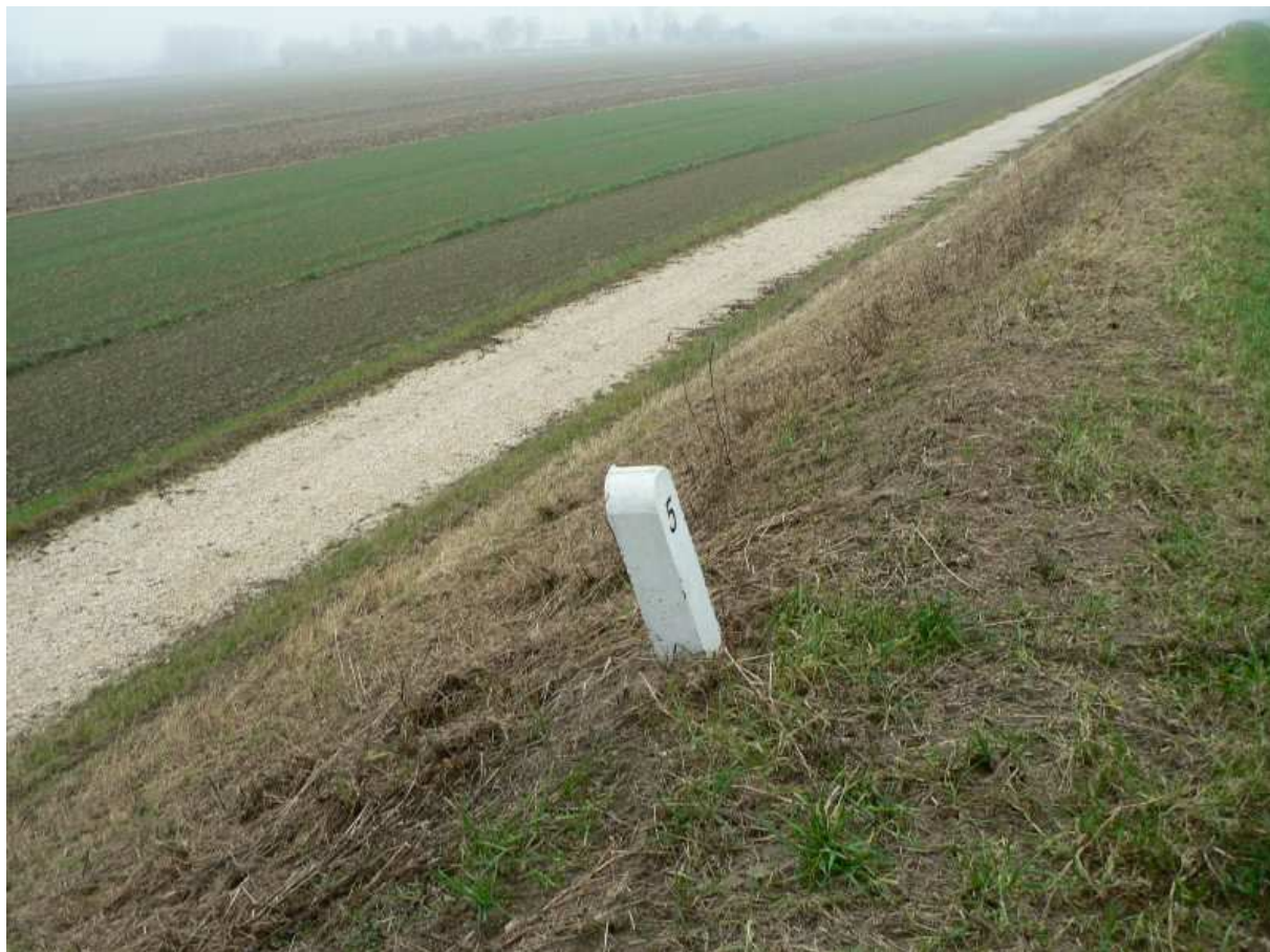
Fot. 12 Skarpa odpowietrzna wału z drogą przywałową na ławce. – Niekurza – Matiaszów.
