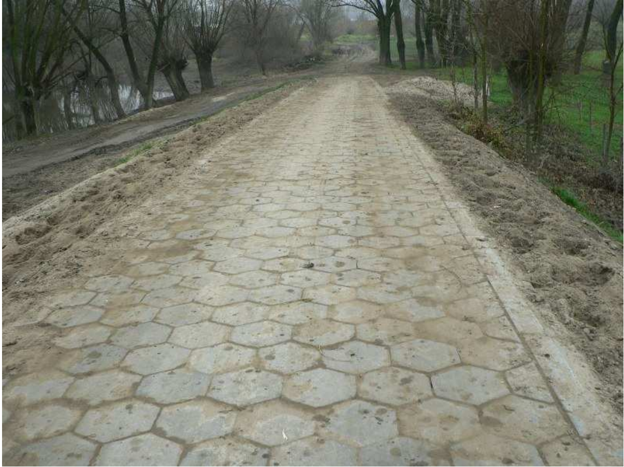
Fot. 17 Rampa wałowa – Niekurza – Matiaszów.
