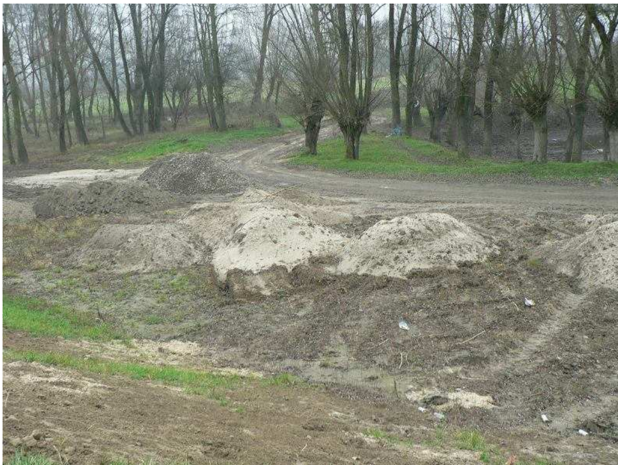
Fot. 15 Ziemia sfałdowana przy stopie wału w celu podwyższenia terenu. – Niekurza – Matiaszów.
