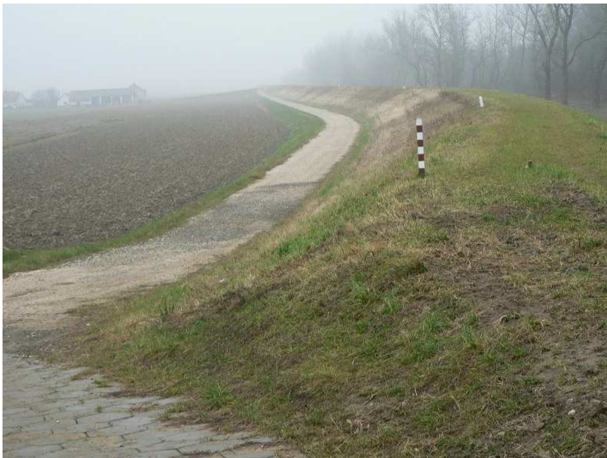
Fot. 5 Korpus wału z drogą przywałową powodziową. – Tarnowce – Słupiec.
