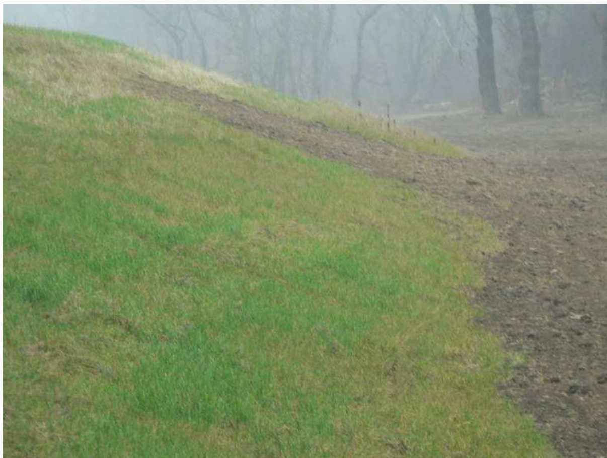
Fot. 3 Skarpa odwodna z widocznym fragmentem odbudowy ( zniszczonej w czasie powodzi) skarpy i przy stopie wału. – Tarnowce – Słupiec.
