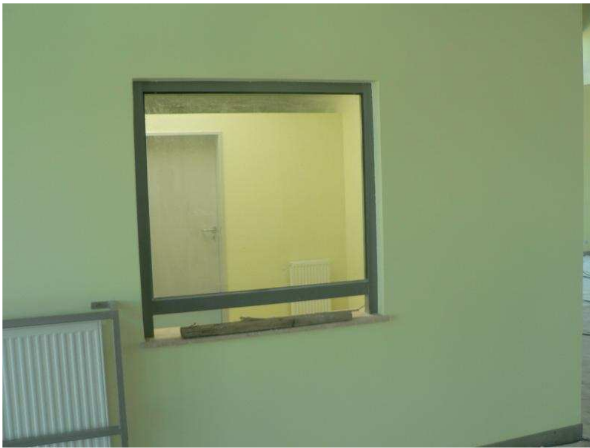
Fot. 5 Kasa biletowa w budynku dworcowym.
