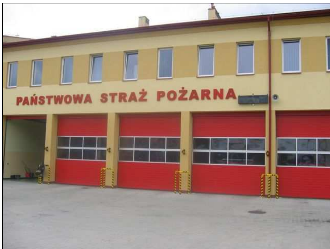
Fot. 6 Budynek JRG nr 3 PSP w Kielcach.
