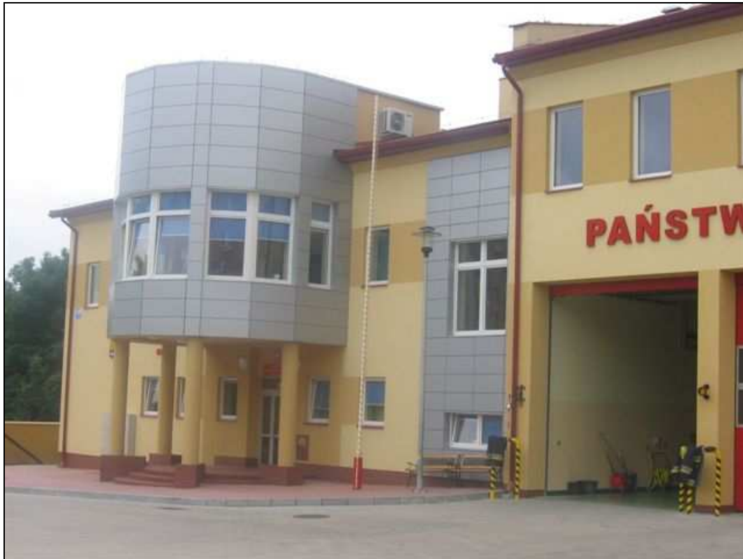
Fot.4 Budynek JRG nr 3 PSP w Kielcach.
