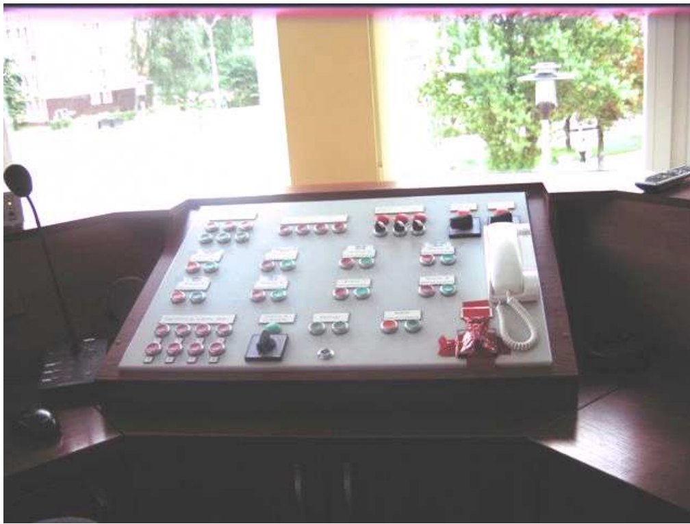
Fot. 10 Pomieszczenie punktu alarmowego (PA).
