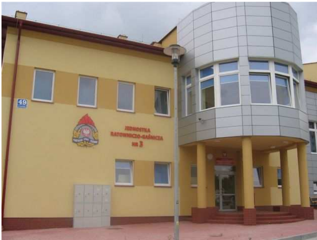
Fot. 1 Budynek JRG nr 3 PSP w Kielcach.
