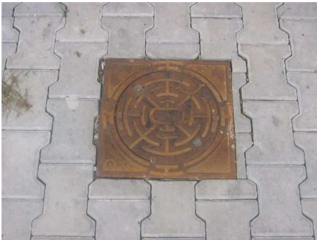
Fot.47 Drenaż odwadniający budynek JRG 3 Kielce.
