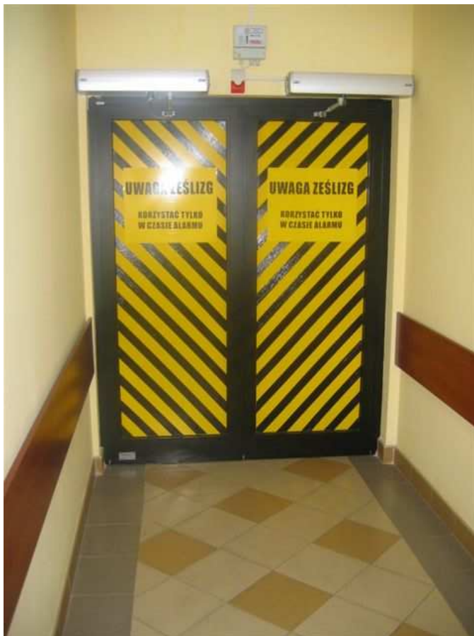
Fot. 29 Drzwi do pomieszczenia ześlizgu ze sterowaniem automatycznym.
