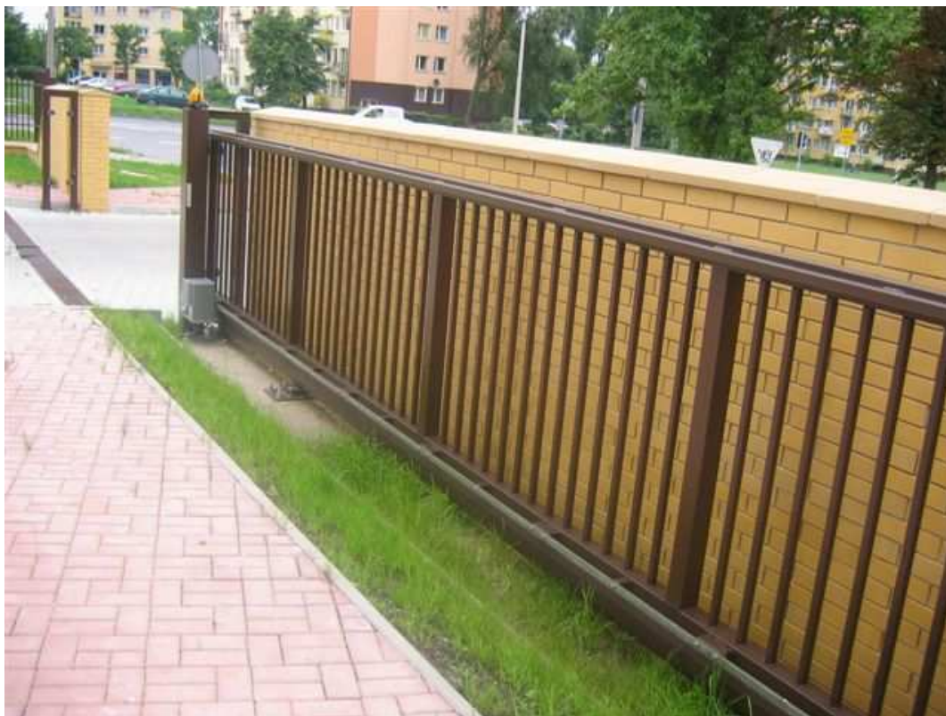
Fot. 56 Ogrodzenie i automatyczna brama wjazdowa do JRG 3 Kielce.
