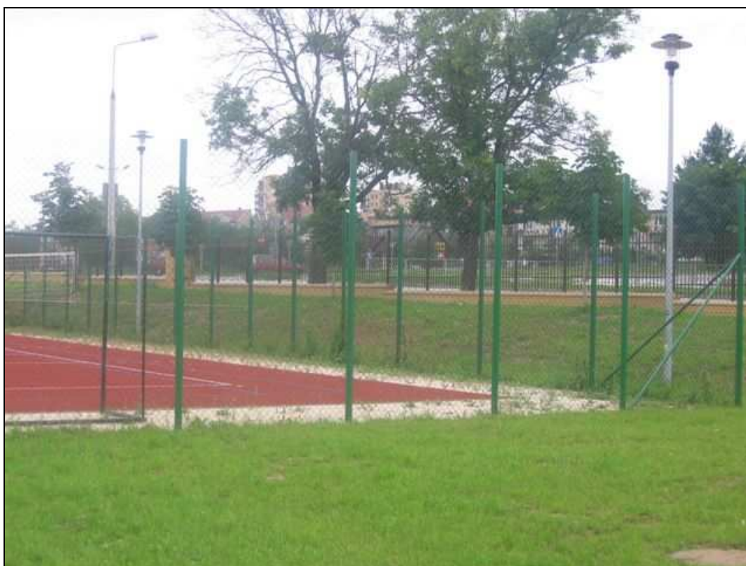
Fot. 54 Ogrodzenie boiska, oświetlenie placu zewnętrznego.
