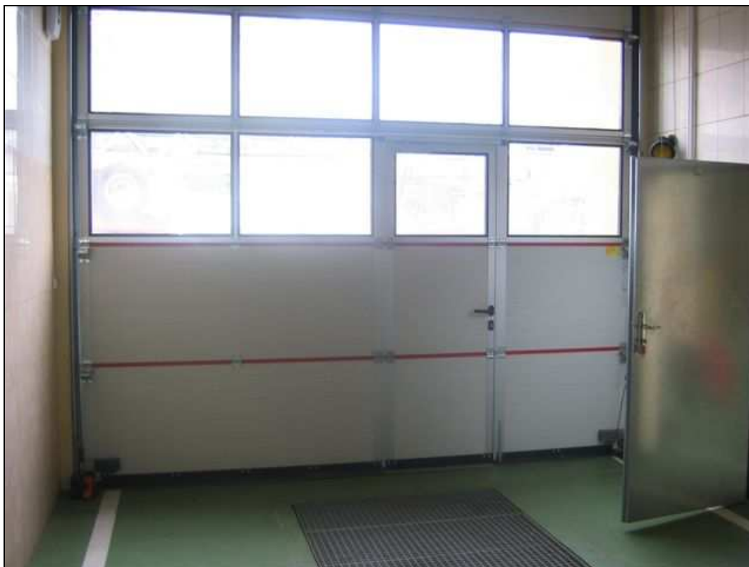
Fot. 41 Brama wjazdowa do pomieszczenia myjni.
