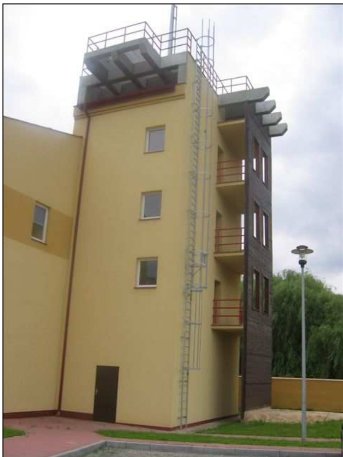
Fot. 51 Widok wieży do ćwiczeń.
