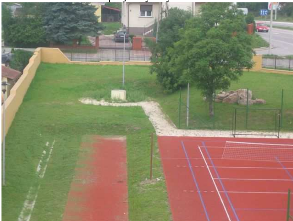
Fot. 37 Boisko, bieżnia, studnia, ogrodzenie elementy małej architektury.
