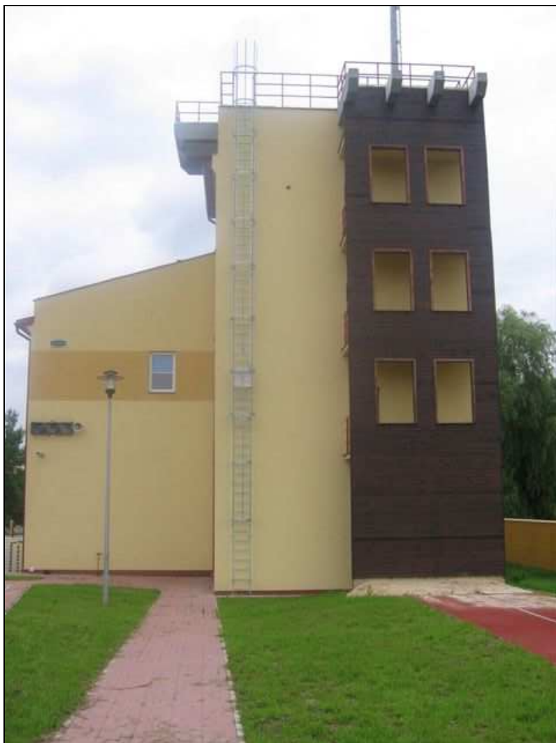
Fot. 55 Widok wieży i wspinalni wraz z poduszką amortyzującą.
