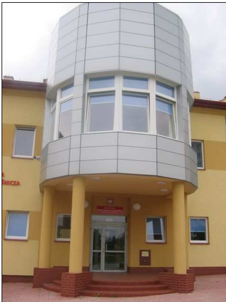
Fot. 8 Budynek JRG nr 3 PSP w Kielcach – punkt alarmowy.
