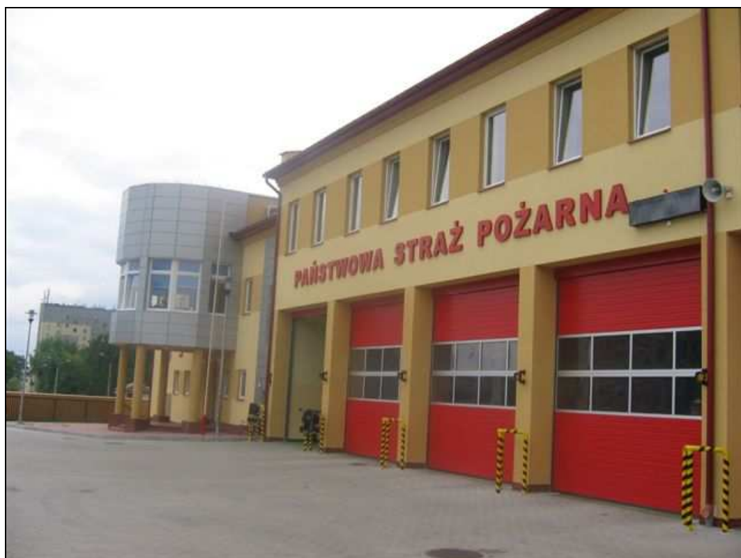
Fot. 3 Budynek JRG nr 3 PSP w Kielcach – widok od frontu.
