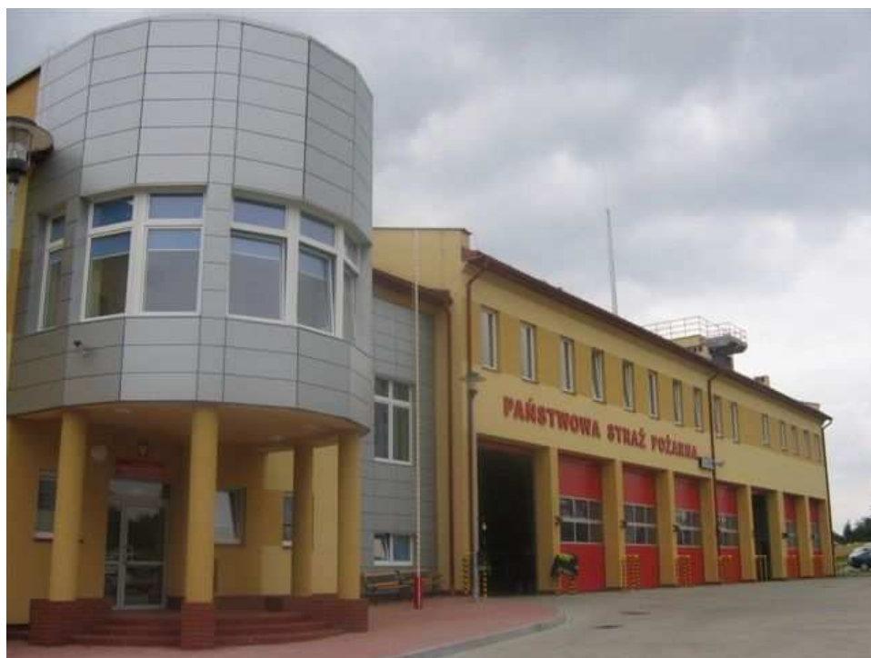
Fot.7 Budynek JRG nr 3 PSP w Kielcach – widok na osiem stanowisk garażowych i punkt alarmowy.
