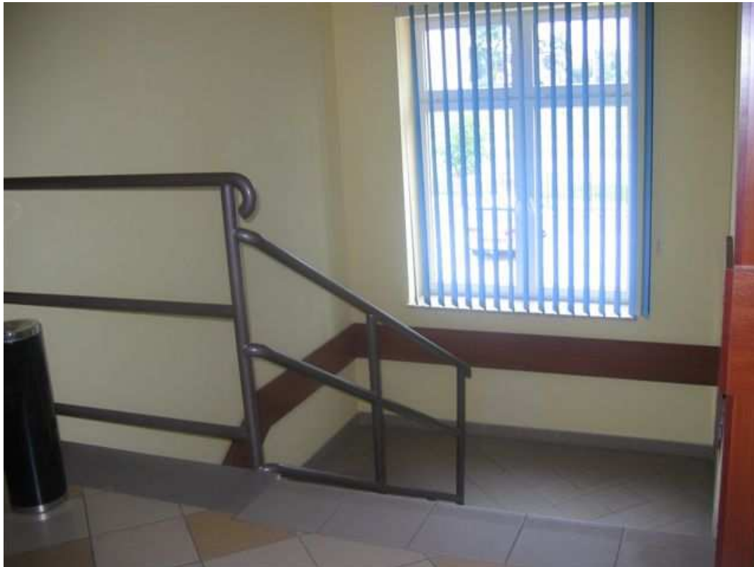
Fot.16 Klatka schodowa na półpiętro.
