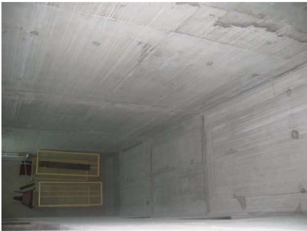
Fot. 34 Wieża ćwiczeń specjalistycznych.
