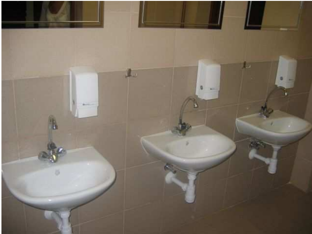
Fot.64 Pomieszczenia sanitarne.
