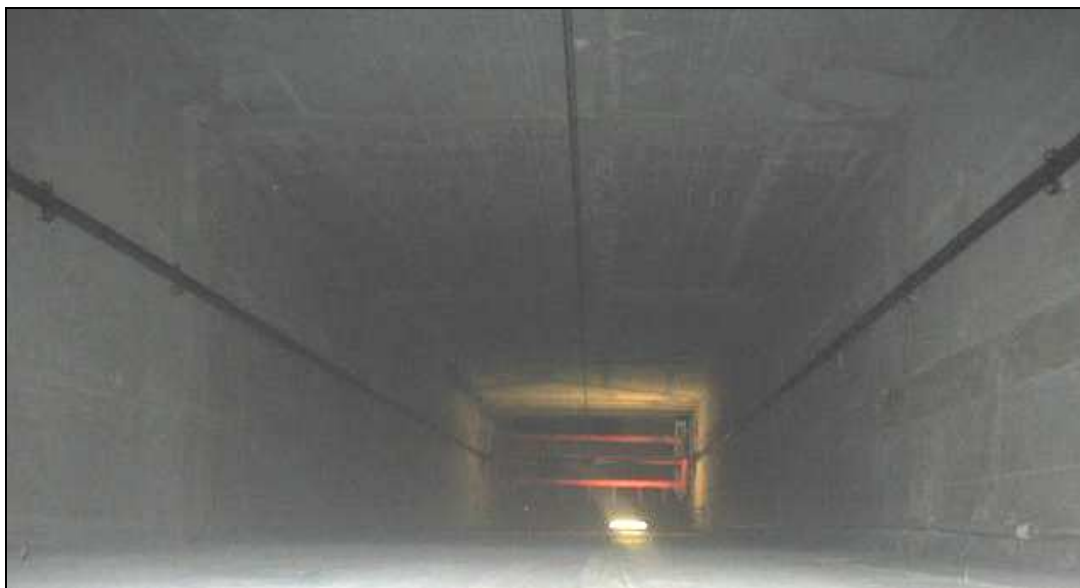
Fot. 32 Suszarnia węży wraz z mechanizmem wyciągu węży.
