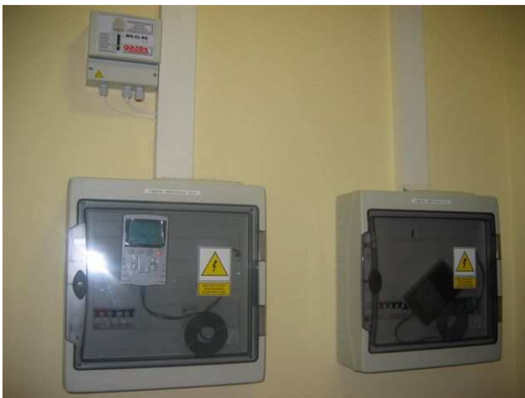
Fot. 27 Sterowanie wentylacją mechaniczną.
