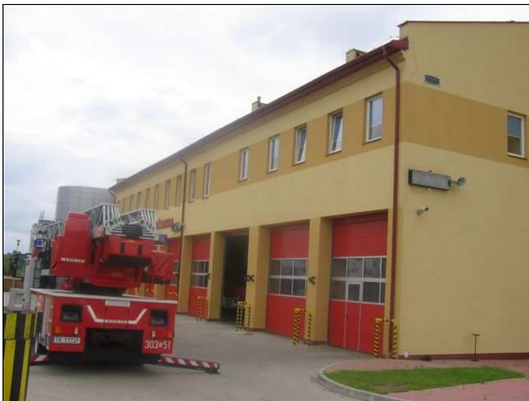
Fot. 52 Budynek JRG nr 3 PSP w Kielcach.
