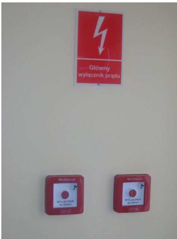
Fot. 67 Główny wyłącznik prądu.
