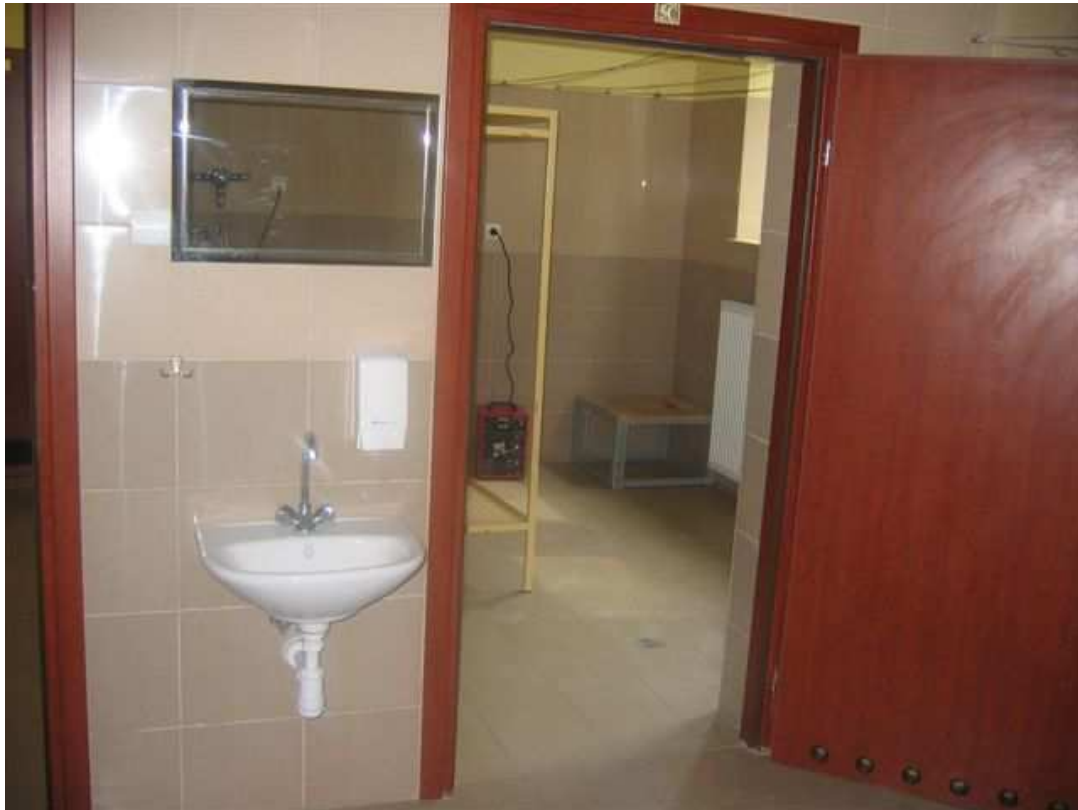
Fot. 66 Pomieszczenia sanitarne.
