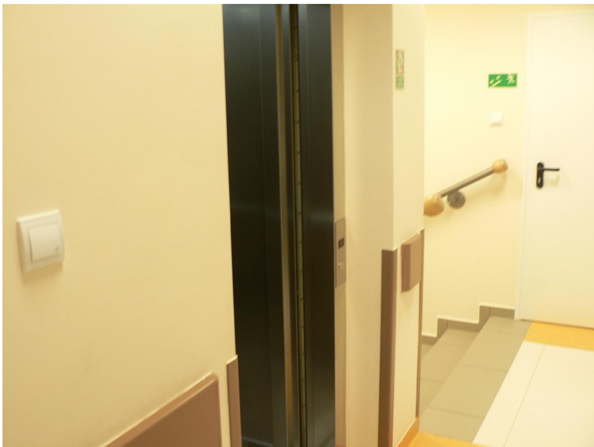
Widoczny szyb windowy wraz z odbojnicami na klatce schodowej - bka nr 17 - Kielce
