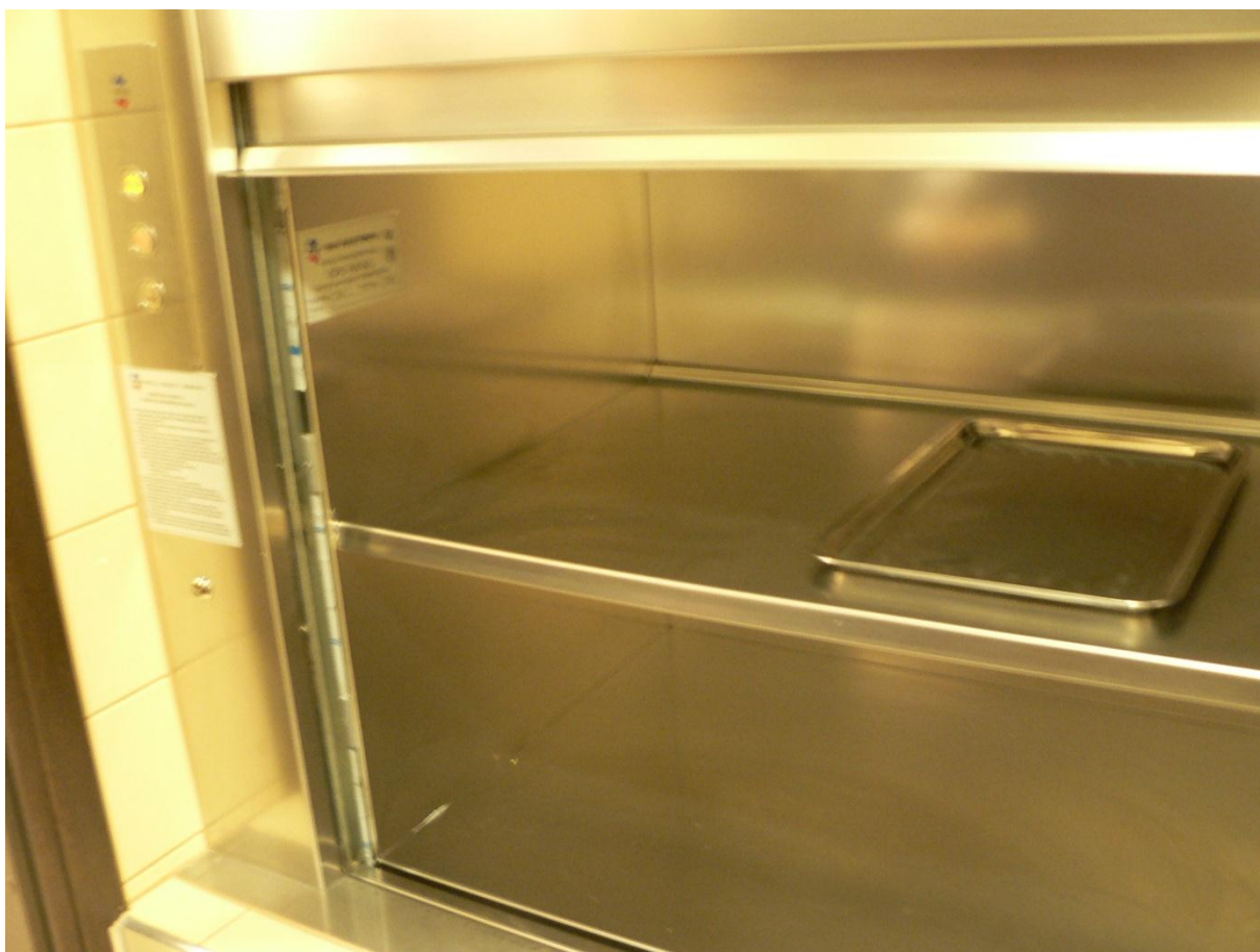
Winda przekazująca posiłki i naczynia w Śbku nr 17 - Kielce
