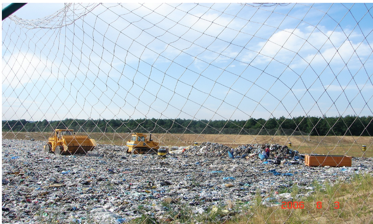
Zdjęcie 11. Eksploatacja kwatery składowania odpadów nr 2 - ZUOK Janczyce
