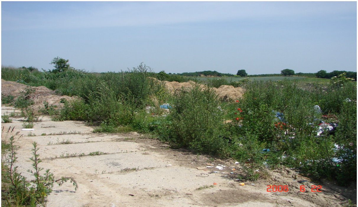
Zdjęcie 38. Zamknięte i zrehabilitowane w 2002 składowisko w Samborcu o powierzchni 0,80 ha
