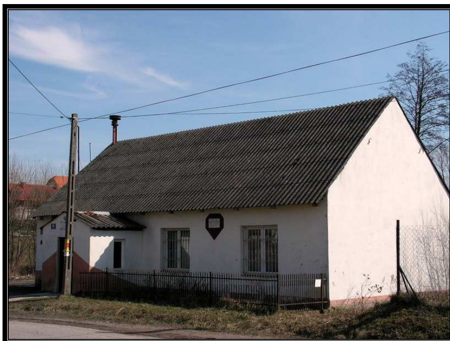
Budynek remizy OSP w Woli Kopcowej
