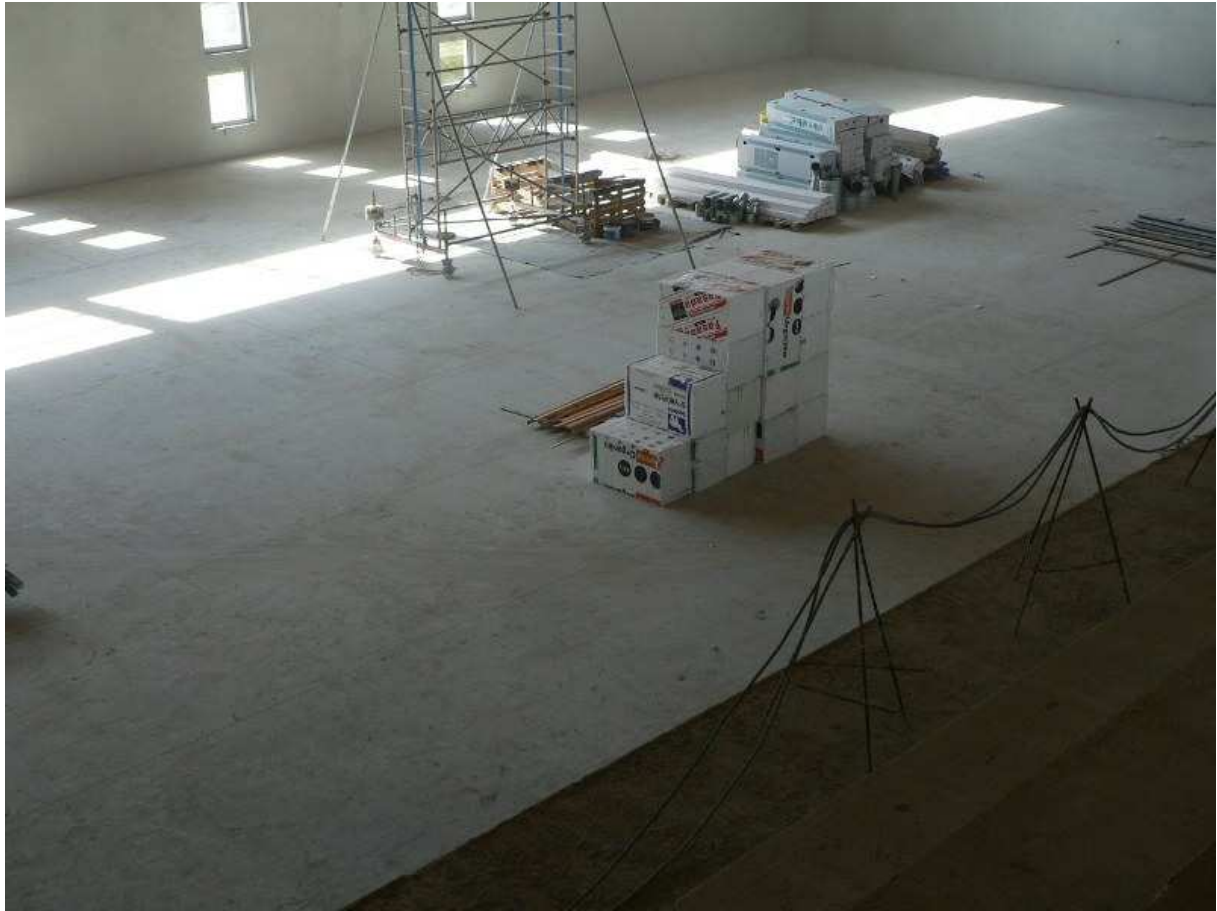
Zdj. 9 Hala Sportowa - stan surowy.
