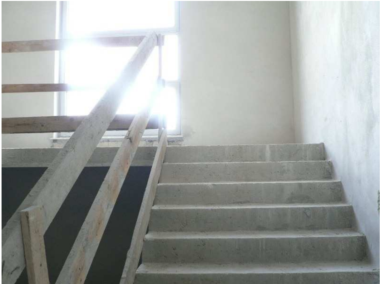
Zdj. 2 Schody prowadzące na piętro ( w części kawiarnianej ).
