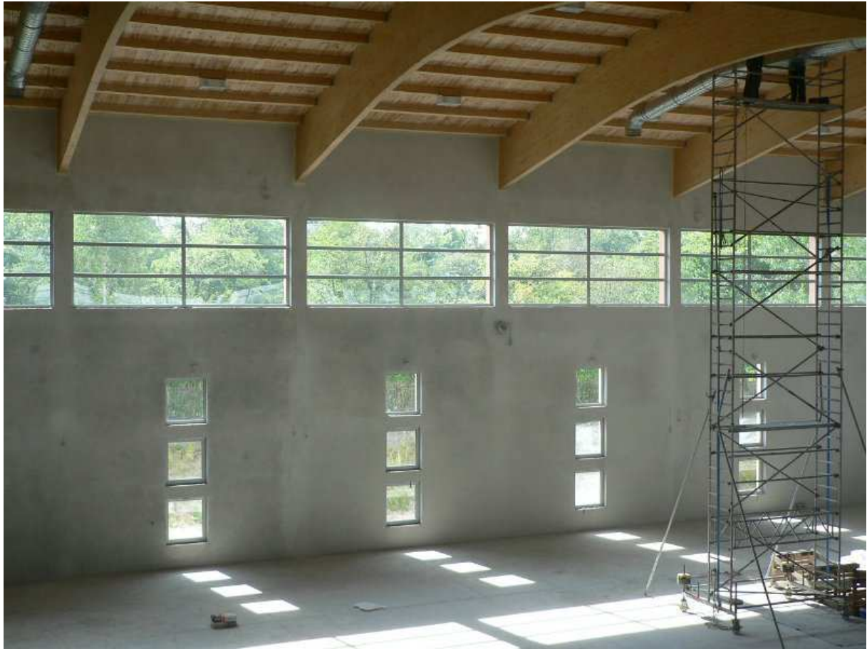
Zdj. 10 Zadaszenie wewnątrz Hali Sportowej.
