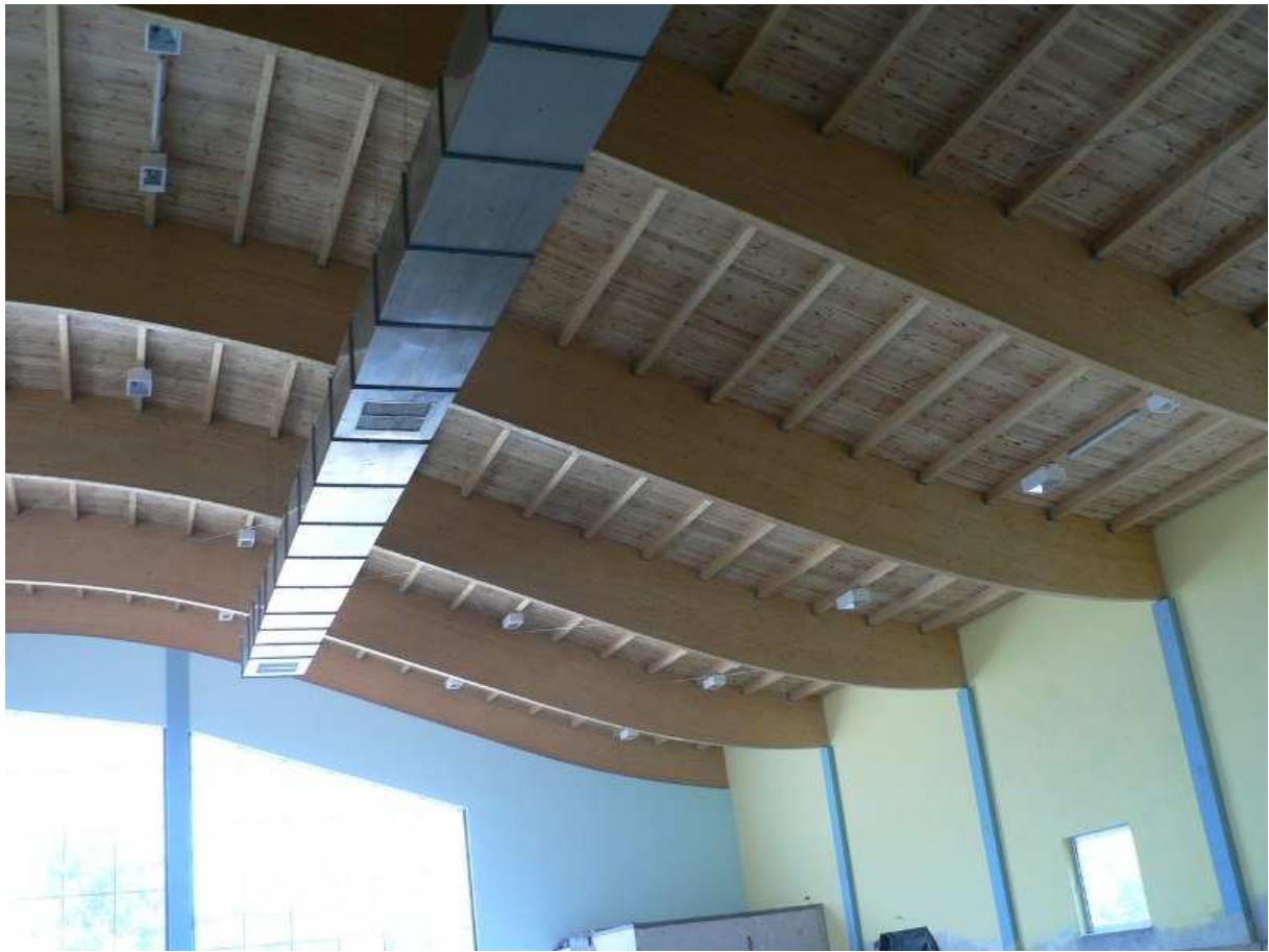
Zdj. 5 Sufit – Hala basenowa – zadaszenie od wewnątrz.
