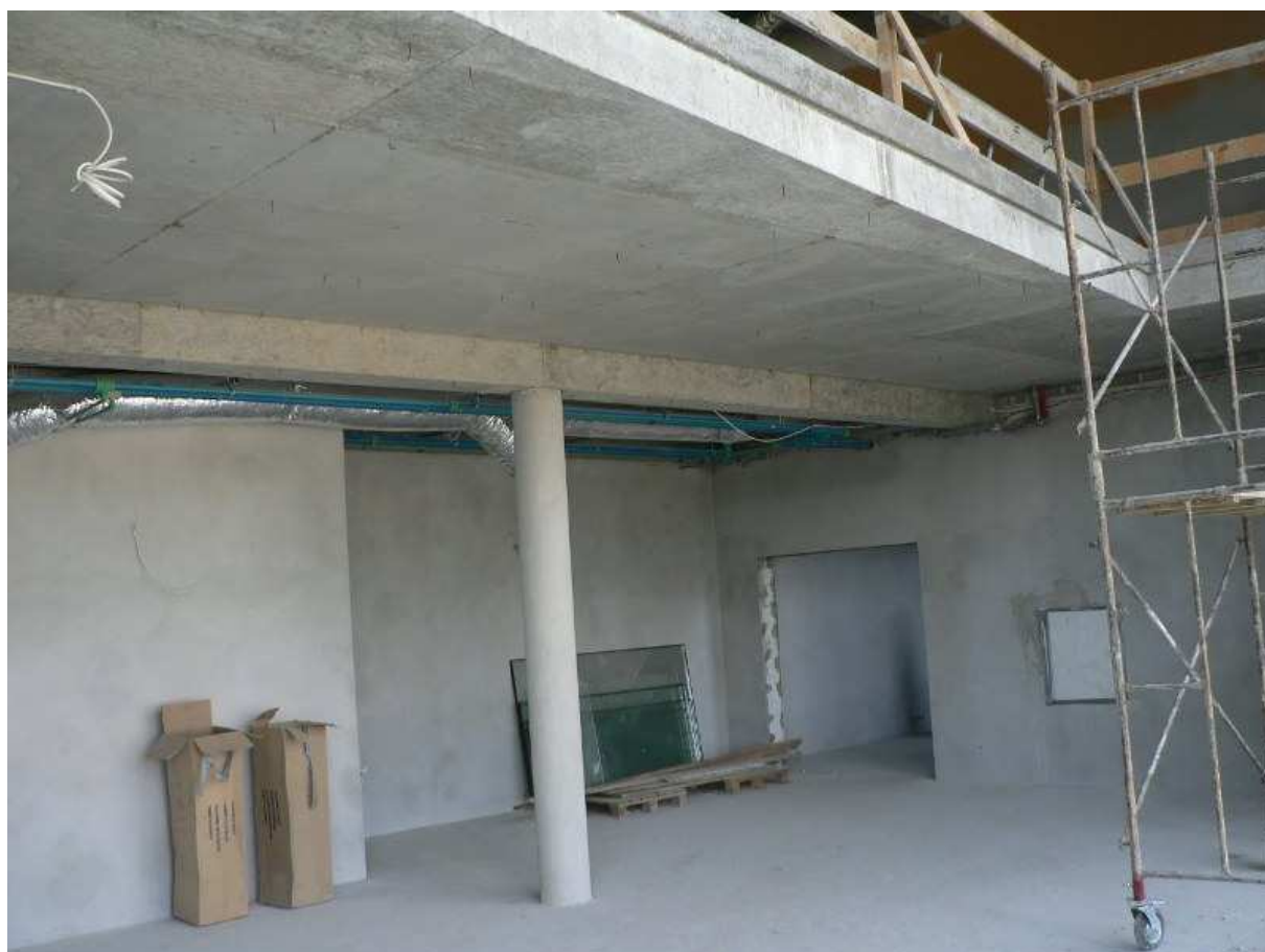
Zdj. 1 Wejście na Halę Sportową od strony basenu.
