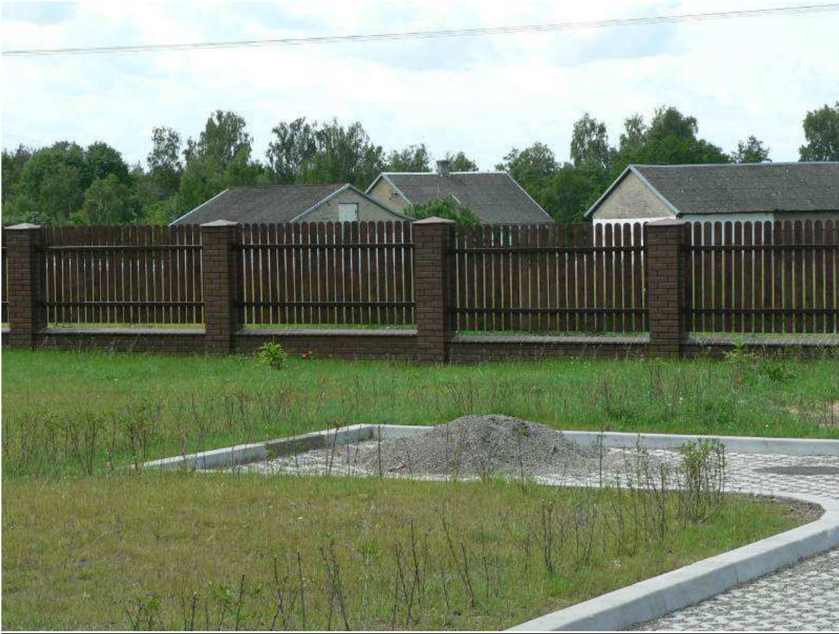
Ogrodzenie wraz z żywoplotem.
