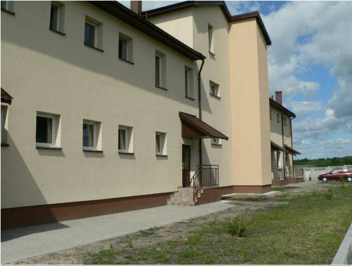
Budynek Ośrodka Wychowawczego w Rembowie
