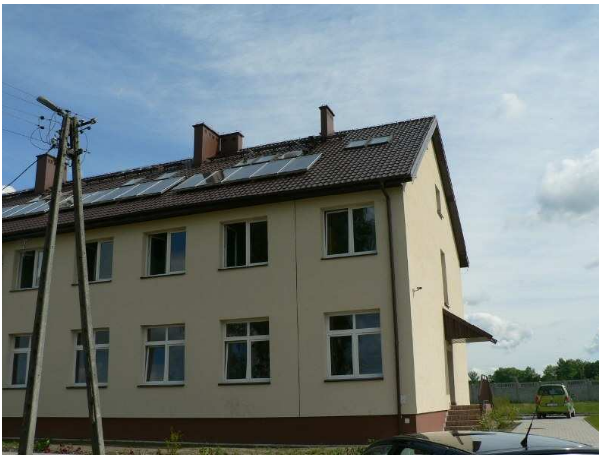
Budynek Ośrodka Wychowawczego w Rembowie
