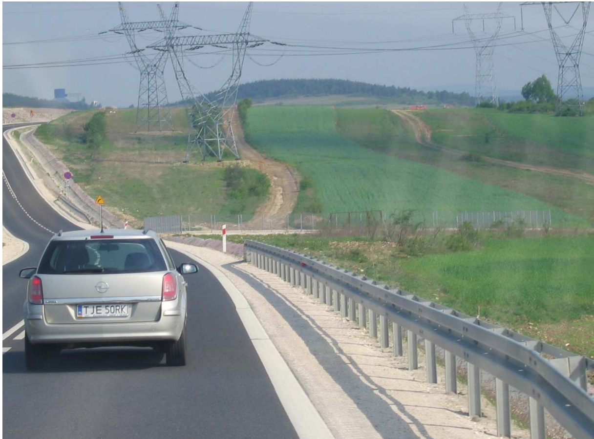
„ Nr 728 budowa obwodnicy miejscowości Małogoszcz – II etap wraz z przebudową drogi na odcinku Mieronice – Mniszek 141+880 – 148+000”
