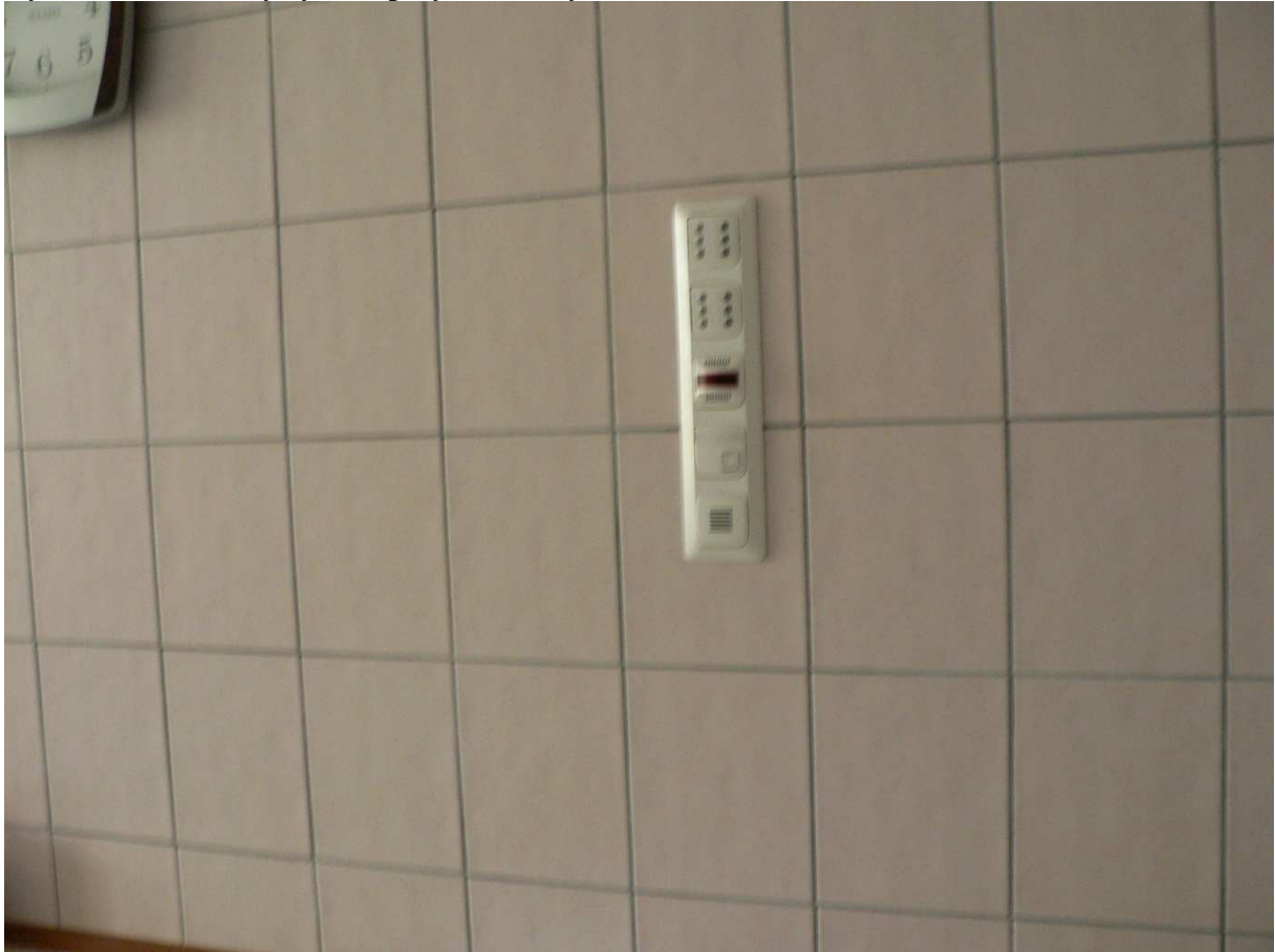
Rys.14 Wewnętrzny system przywoławczy
