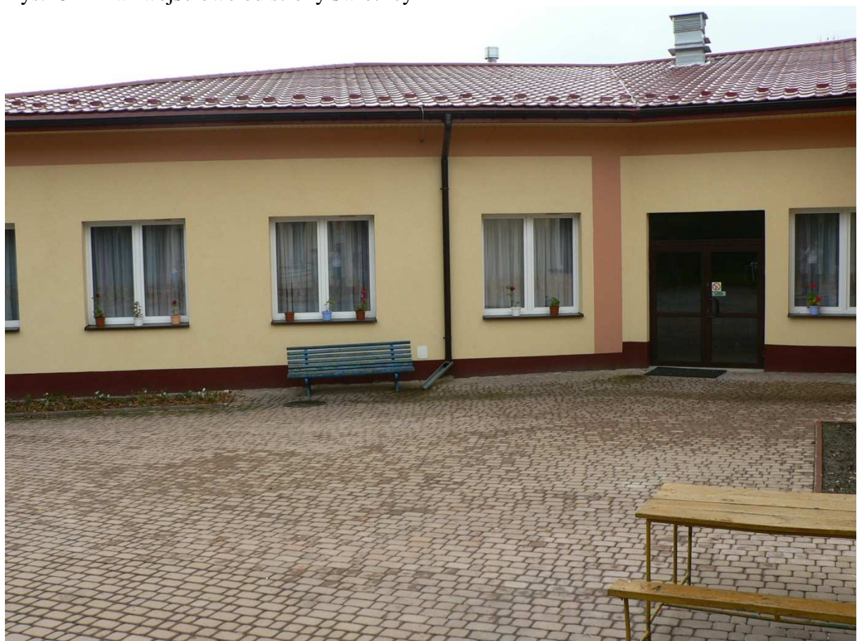
Rys.28 Drzwi wejściowe od strony świetlicy
