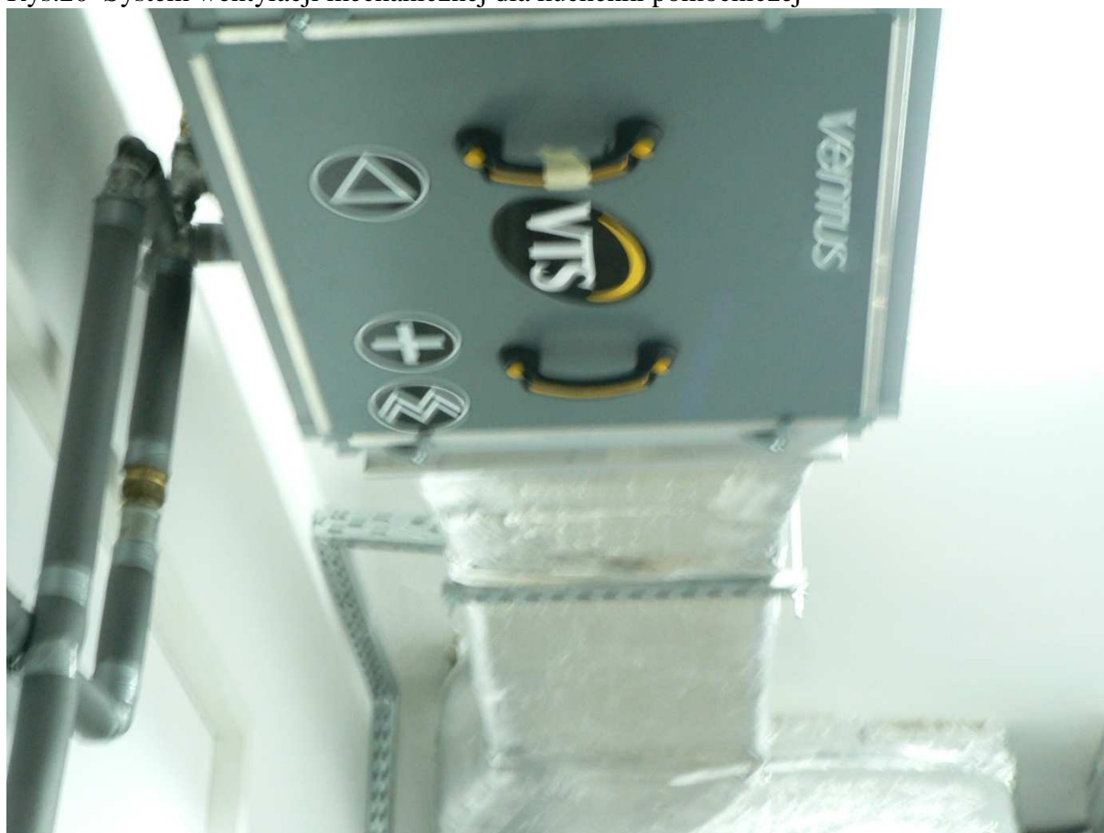
Rys.20 System wentylacji mechanicznej dla kuchenki pomocniczej
