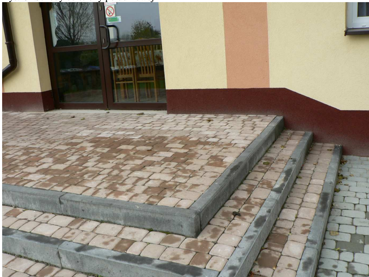
Rys.29 Schody od strony południowej
