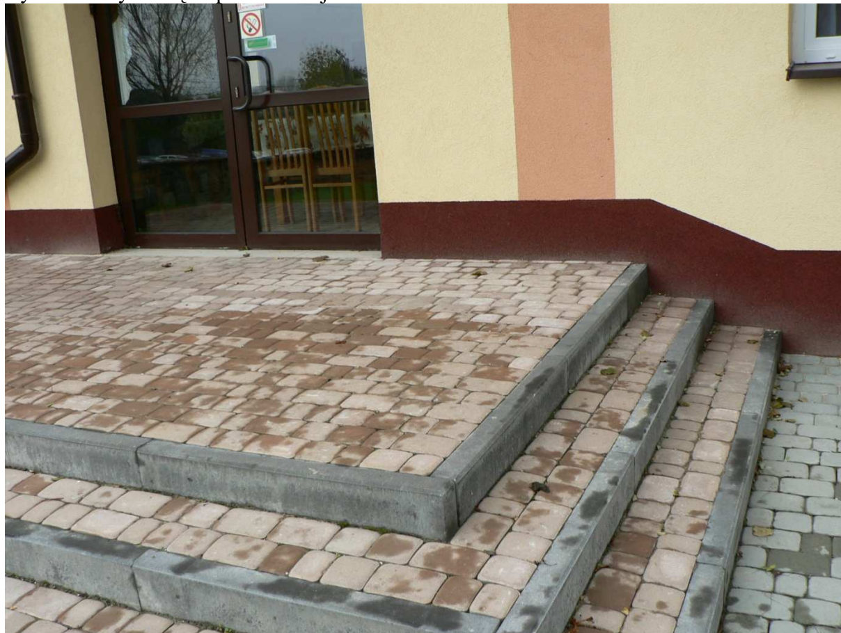
Rys.4 Schody w części południowej
