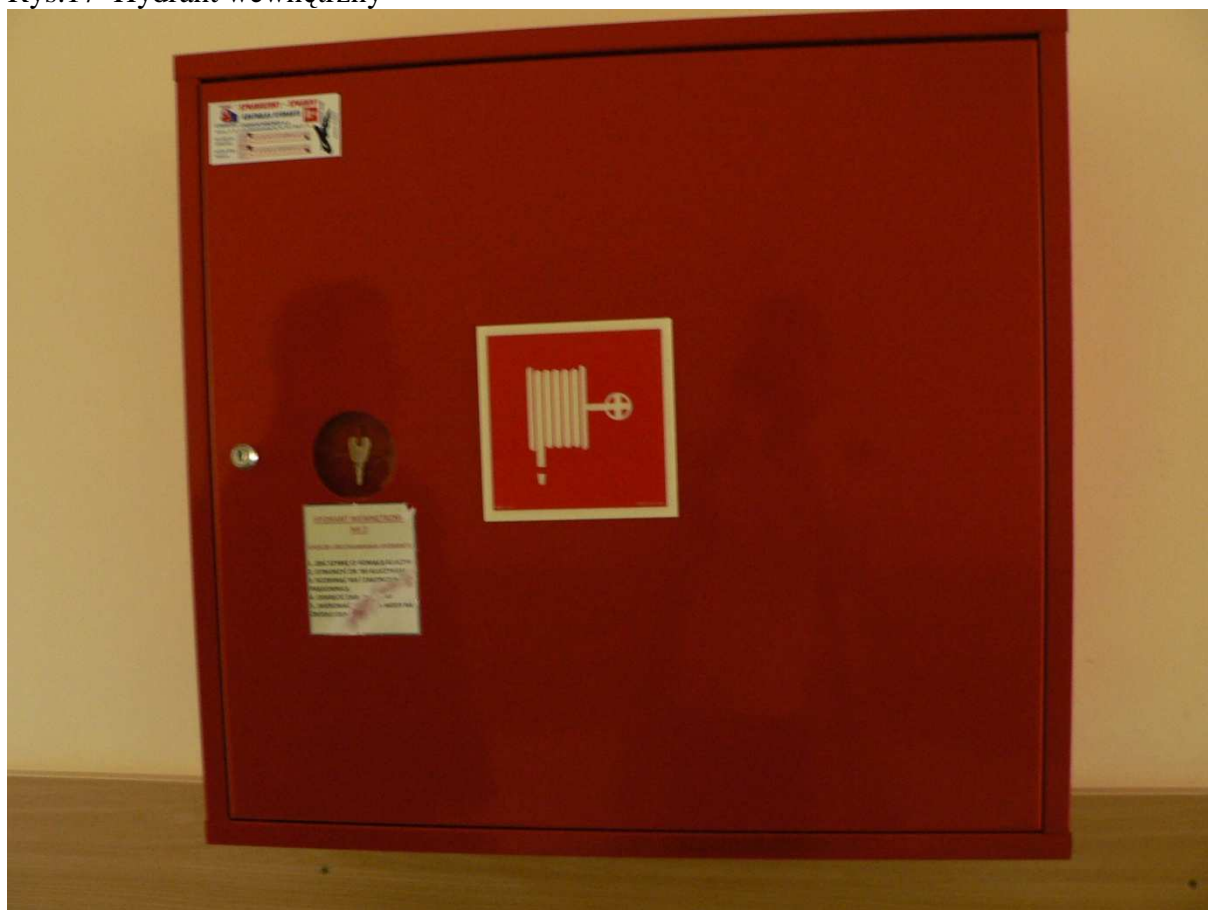
Rys.17 Hydrant wewnętrzny
