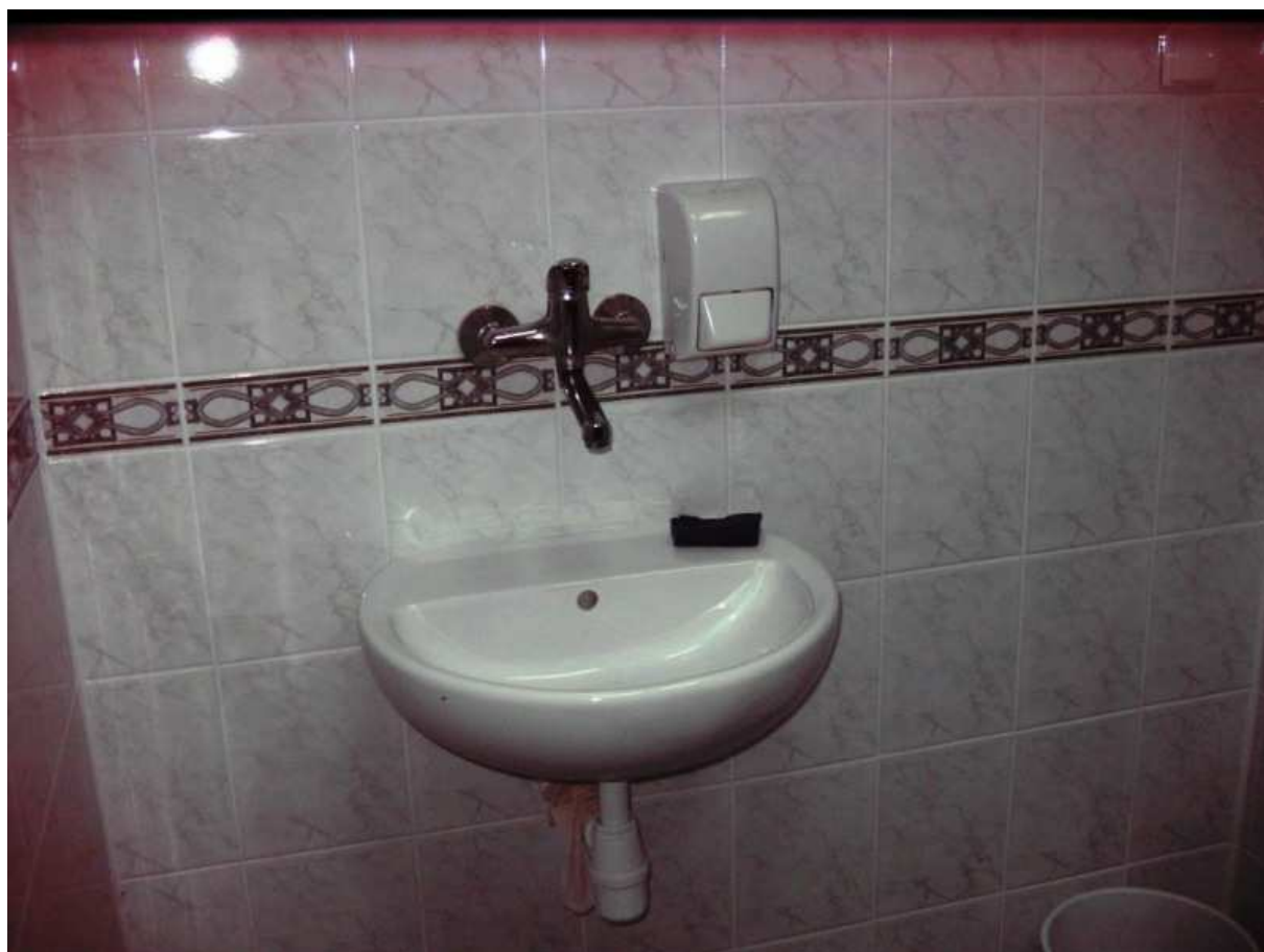
Fot.23. Budynek mieszkalny oddziału dorosłych w Domu Pomocy Społecznej w Mnichowie – pomieszczenie sanitarne
