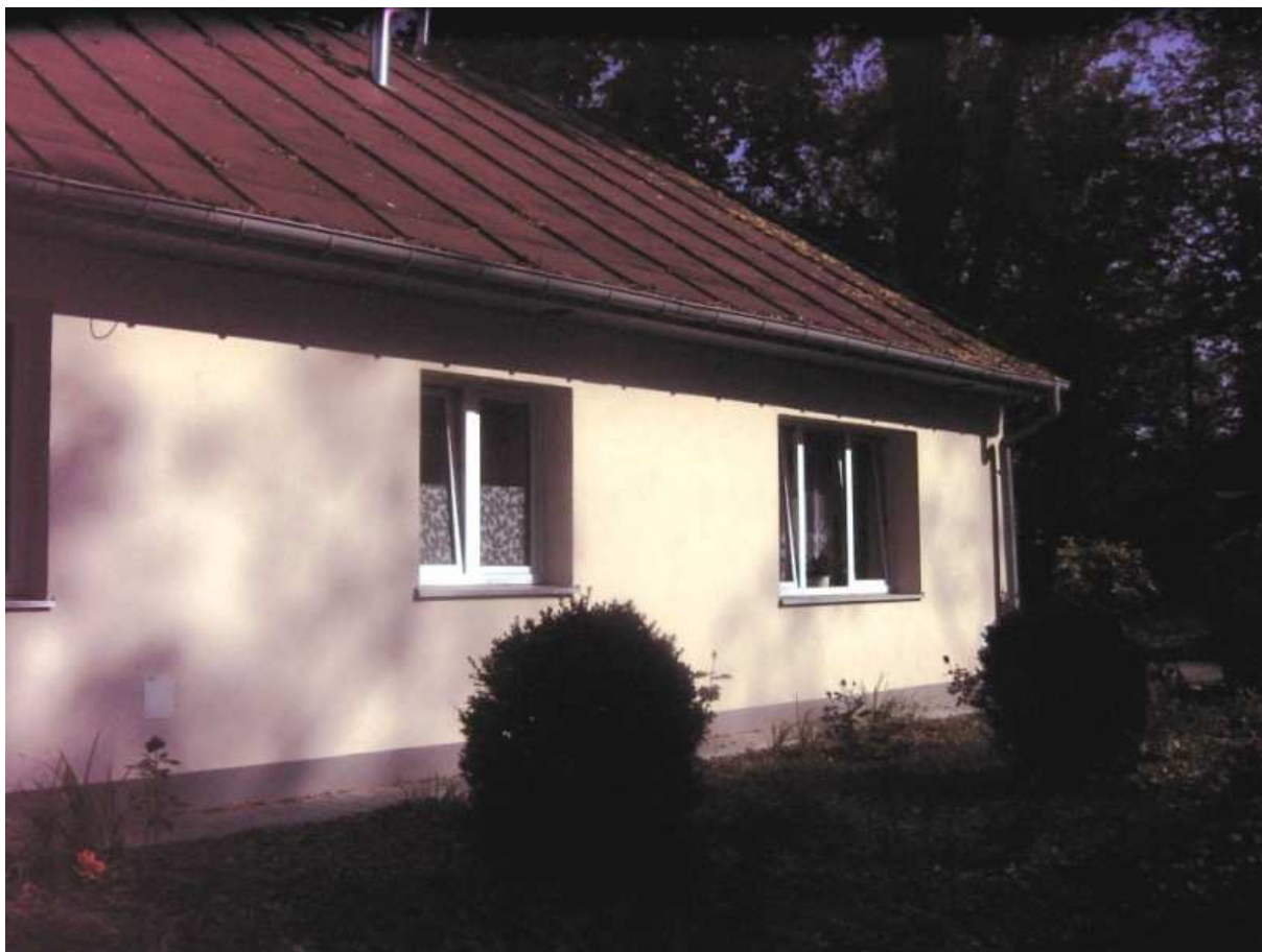
Fot.3. Budynek mieszkalny oddziału dorosłych w Domu Pomocy Społecznej w Mnichowie
