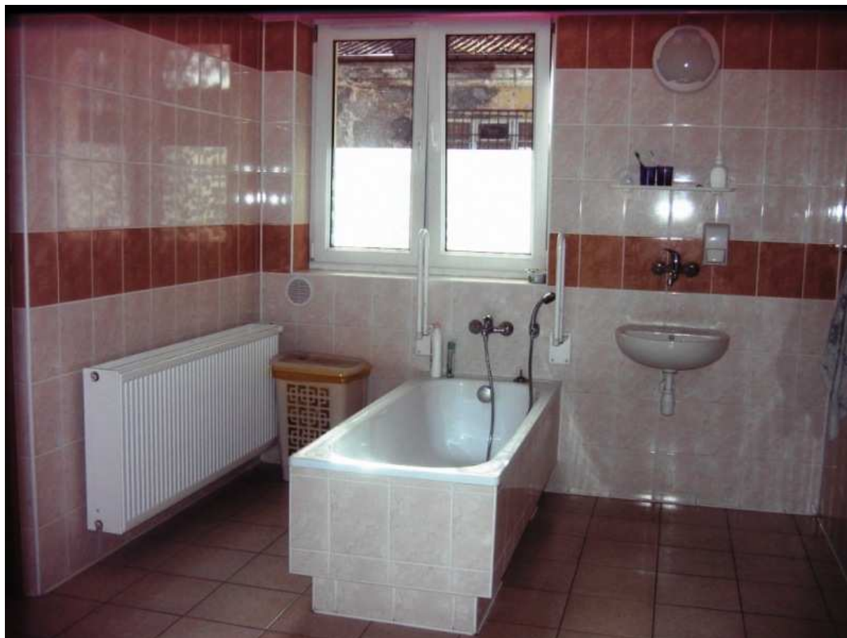
Fot.14. Budynek mieszkalny oddziału dorosłych w Domu Pomocy Społecznej w Mnichowie -łazienka
