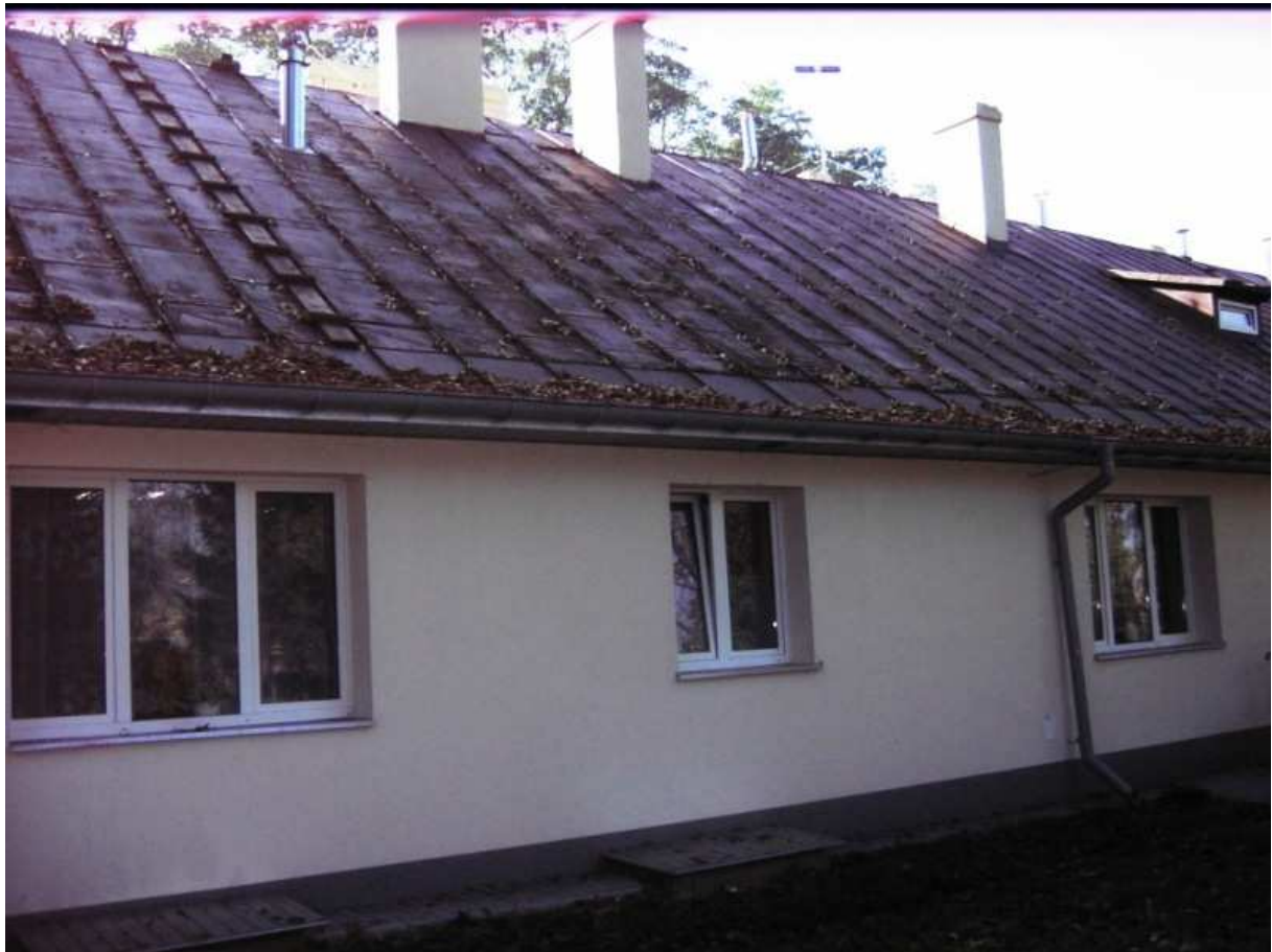
Fot.9. Budynek mieszkalny oddziału dorosłych w Domu Pomocy Społecznej w Mnichowie - wentylacja
