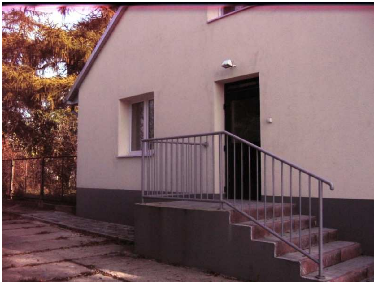
Fot.6. Budynek mieszkalny oddziału dorosłych w Domu Pomocy Społecznej w Mnichowie schody i wejście boczne z monitoringiem zewnętrznym.
