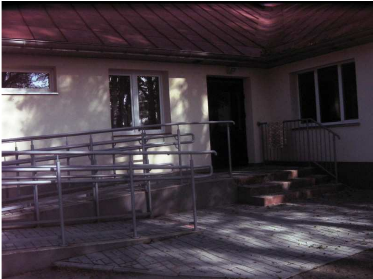
Fot.4. Budynek mieszkalny oddziału dorosłych w Domu Pomocy Społecznej w Mnichowie - wejście dla niepełnosprawnych.
