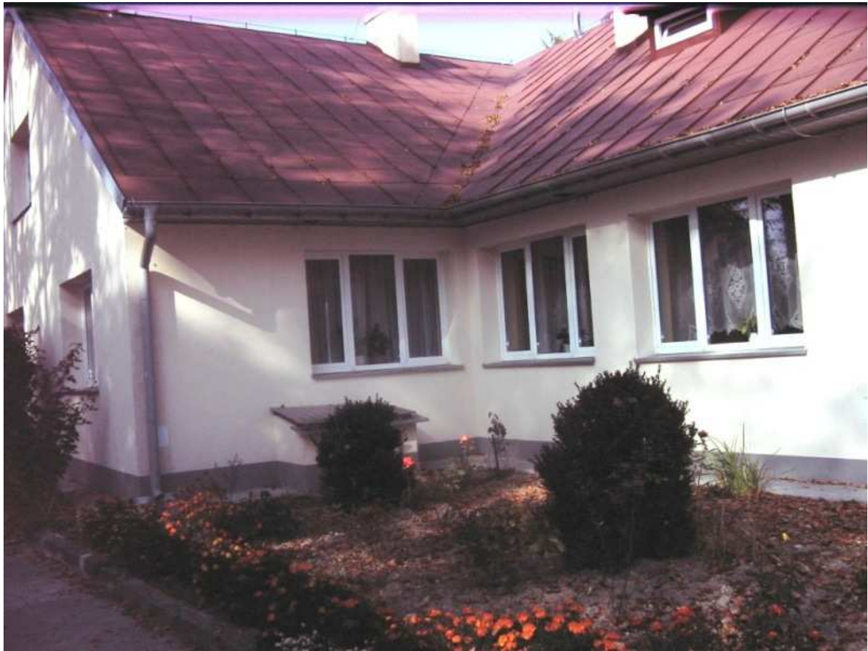
Fot.2. Budynek mieszkalny oddziału dorosłych w Domu Pomocy Społecznej w Mnichowie
