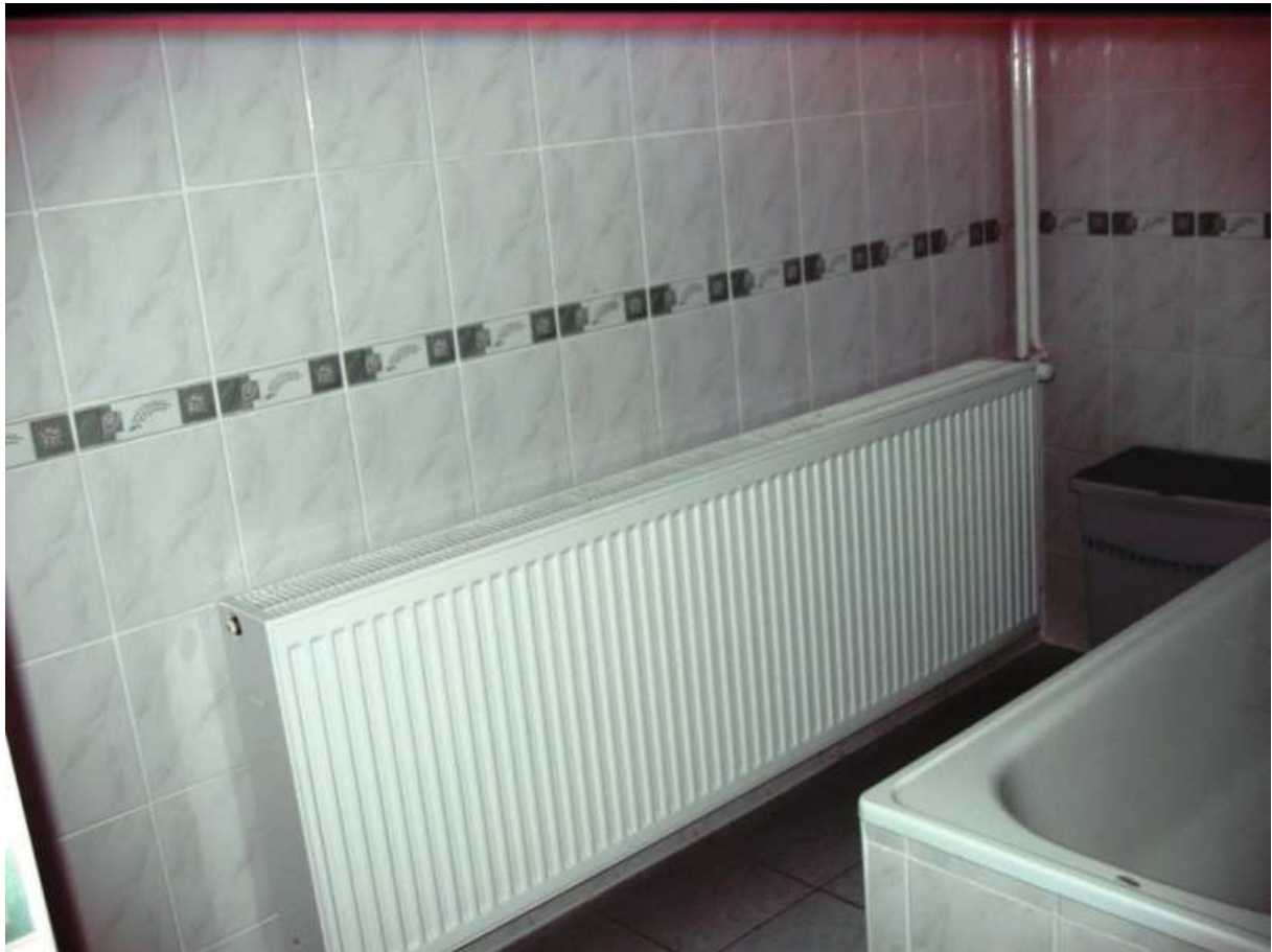
Fot.28. Budynek mieszkalny oddziału dorosłych w Domu Pomocy Społecznej w Mnichowie - łazienka
