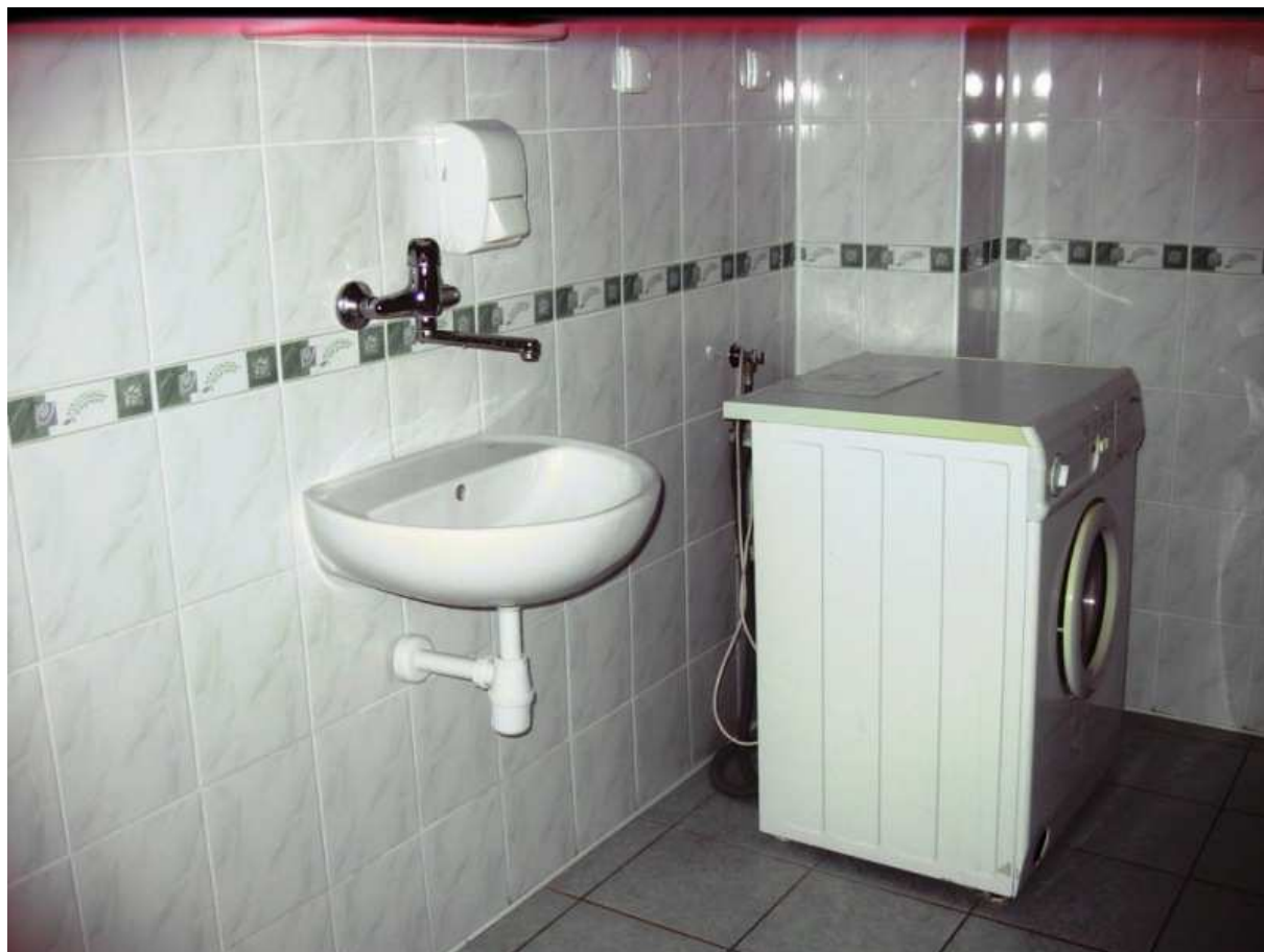
Fot.28. Budynek mieszkalny oddziału dorosłych w Domu Pomocy Społecznej w Mnichowie - pomieszczenie sanitarne
