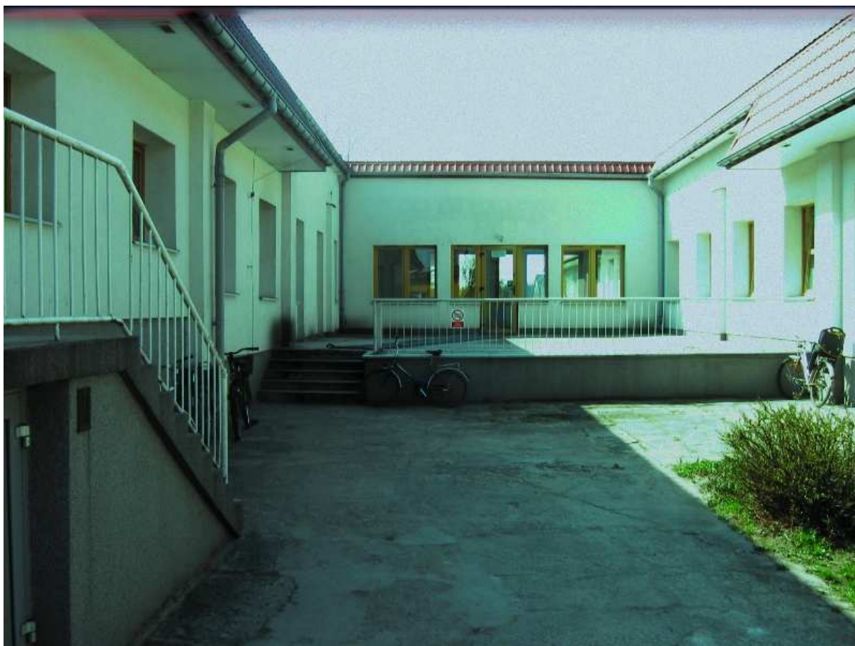
Fot.1. Łącznik budynku głównego w Domu Pomocy Społecznej w Mnichowie
