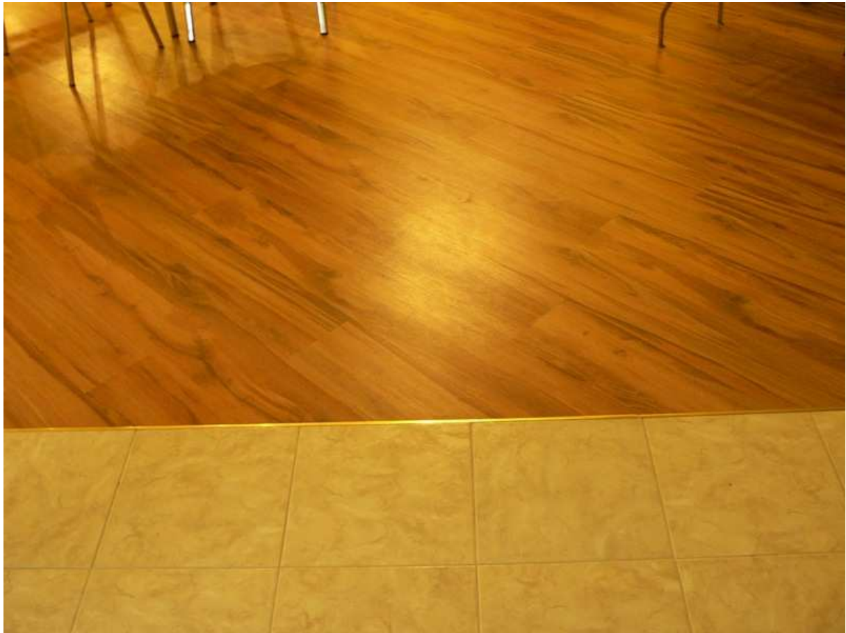
Fot.3 Renowacja podłóg w ŚDS w Kielcach.
