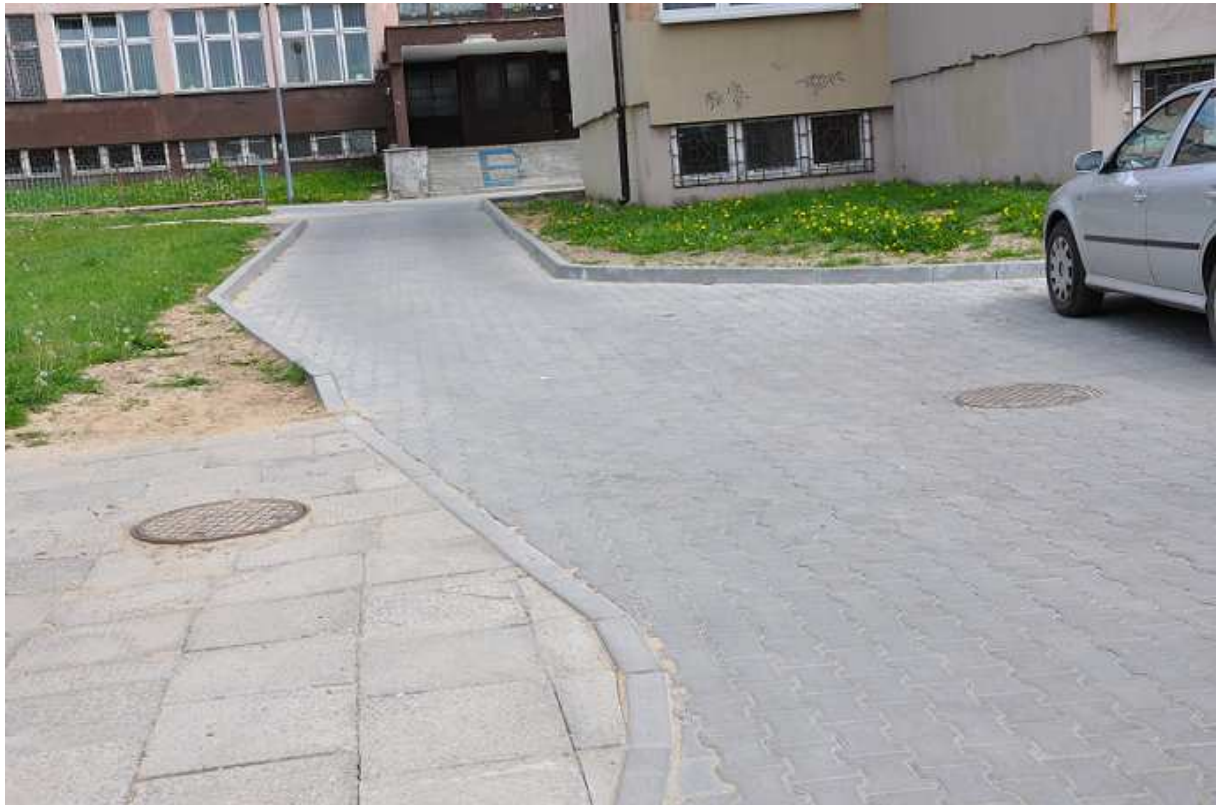
Fot. 12 Droga przeciwpożarowa prowadząca do pomieszczeń ŚDS w Kielcach
