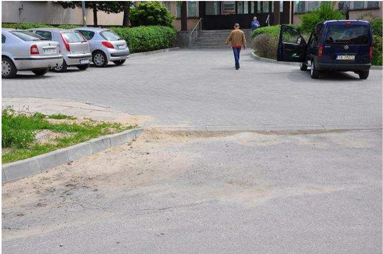
Fot. 11 Zjazd z ul. Krzemionkowej do drogi prowadzącej do pomieszczeń ŚDS w Kielcach
