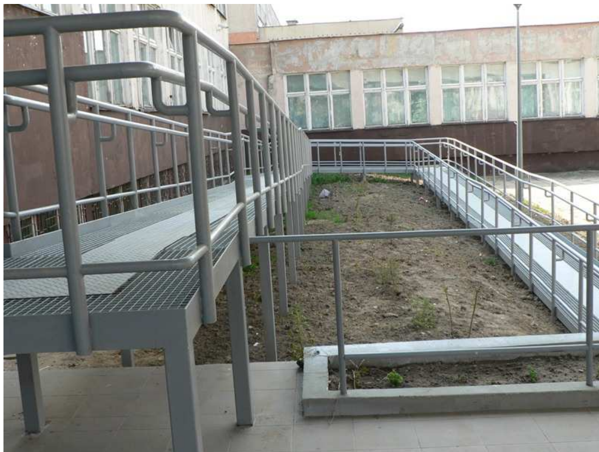
Fot. 1 Podjazd do ŚDS w Kielcach.
