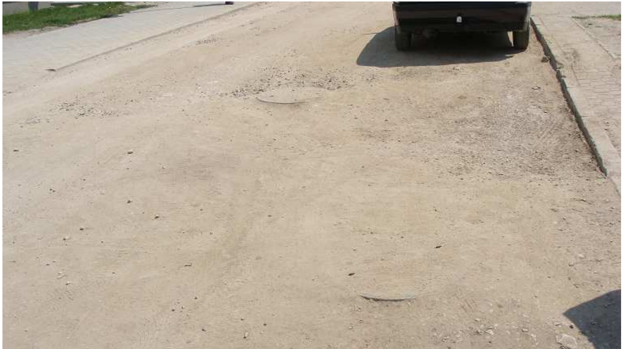
Fot. 13 Budowa kanalizacji deszczowej na ul. Kilińskiego w Busku - Zdroju
