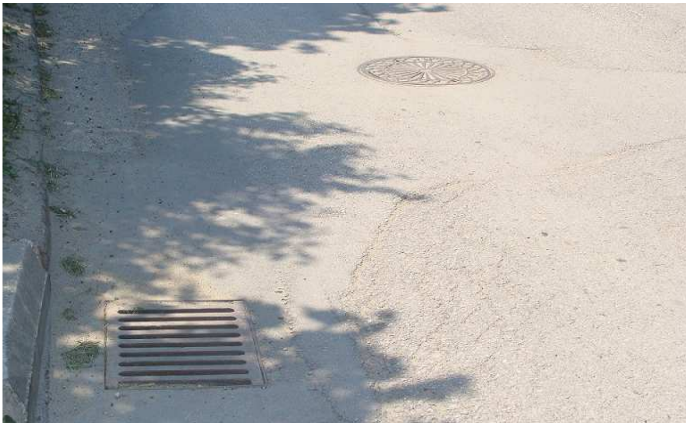
Fot. 1 Kanalizacja deszczowa na ul. Kopernika w Busku - Zdroju
