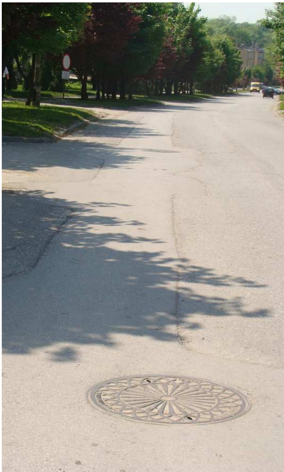
Fot. 2 Kanalizacja deszczowa na ul. Kopernika w Busku - Zdroju
