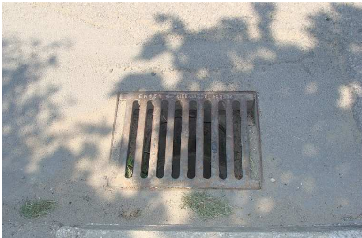
Fot. 3 Wpust uliczny na ul. Kopernika w Busku - Zdroju
