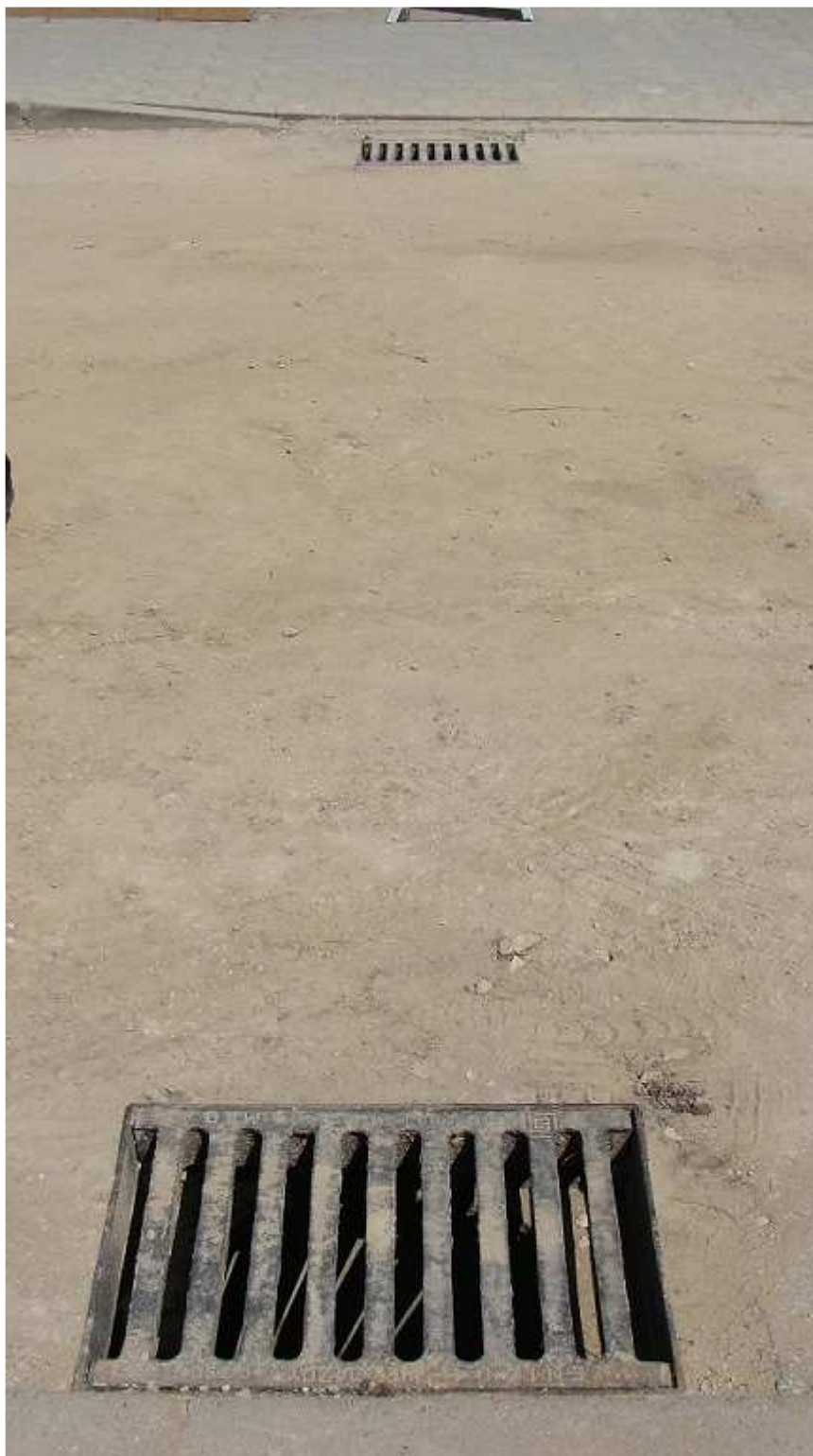
Fot. 17 Wpusty uliczne na ul. Kilińskiego w Busku - Zdroju
