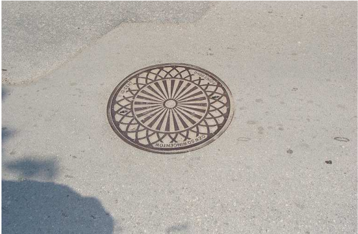
Fot. 4 Właz do studni rewizyjnej na ul. Kopernika w Busku - Zdroju
