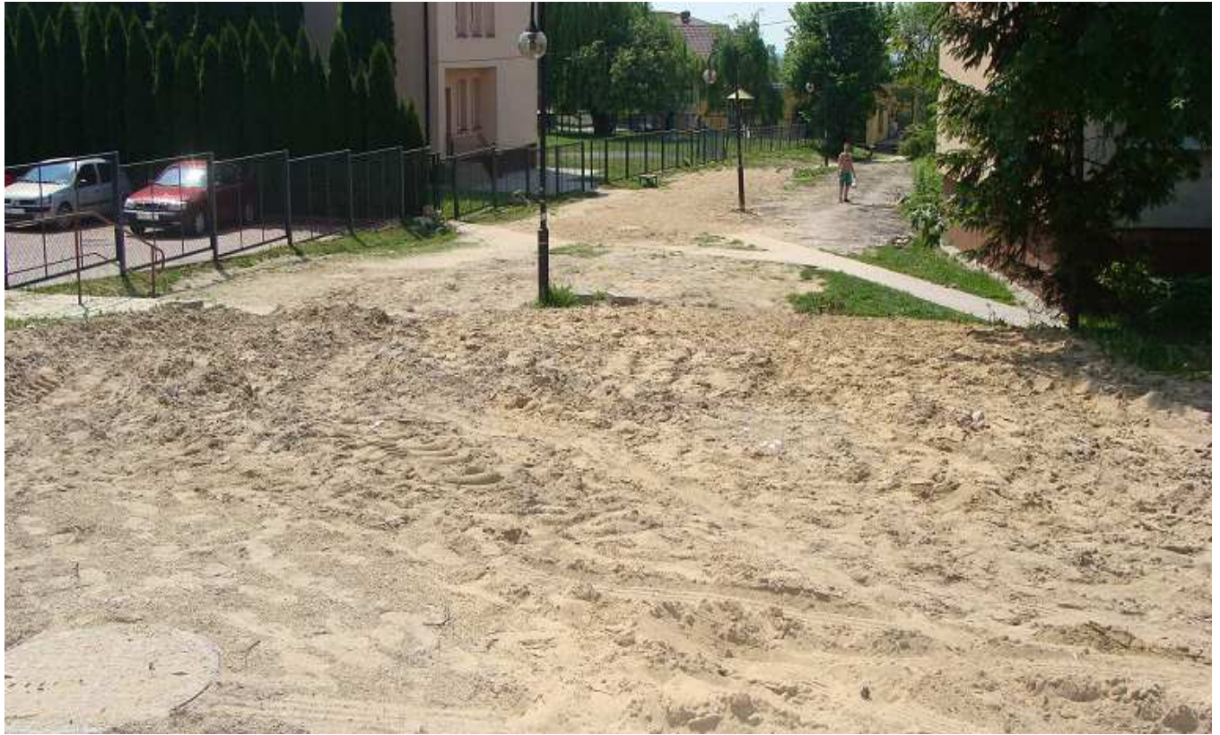
Fot. 7 Budowa kanalizacji deszczowej na ul. Kościuszki w Busku - Zdroju
