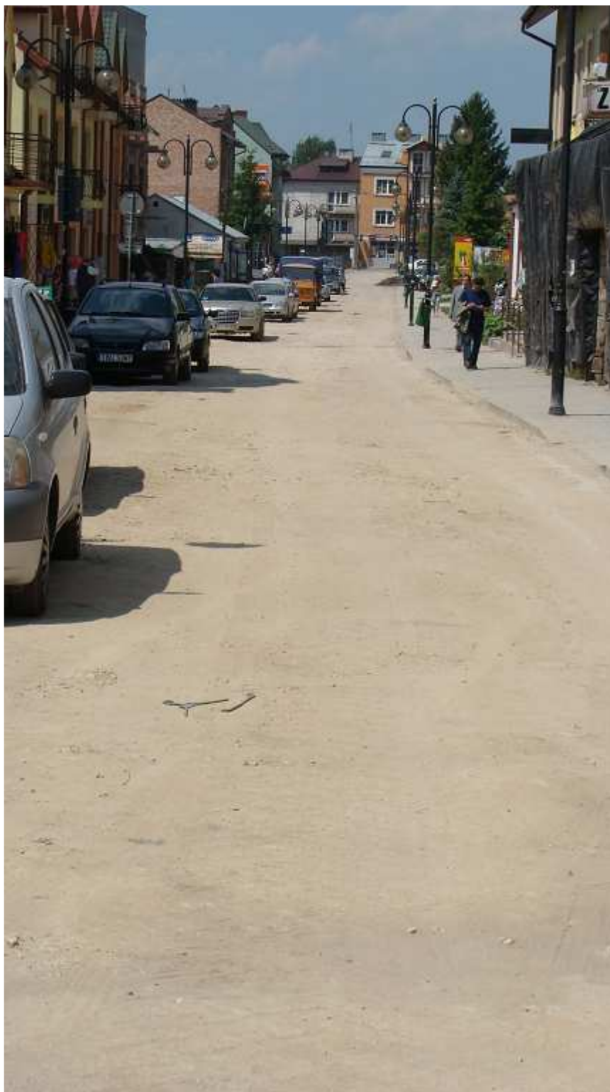
Fot. 16 Budowa kanalizacji deszczowej na ul. Kilińskiego w Busku - Zdroju
