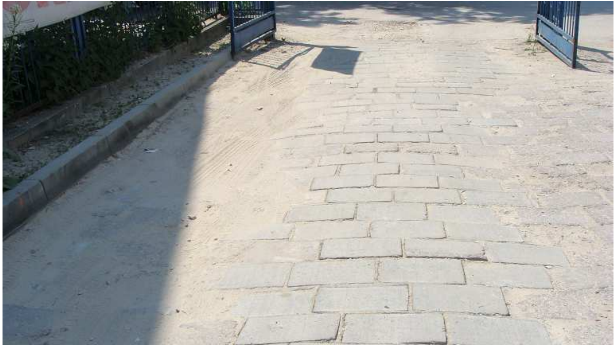
Fot. 12 Kanalizacja deszczowa na ul. Kościuszki w Busku - Zdroju
