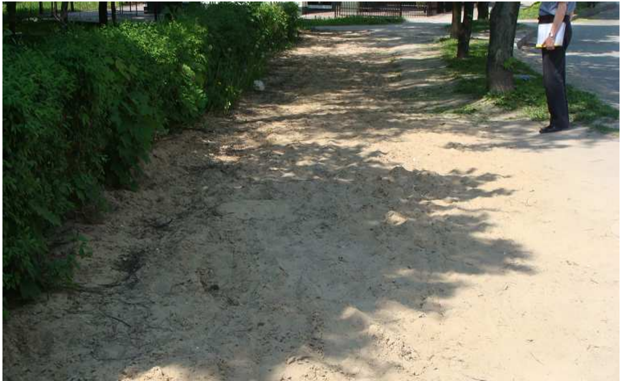
Fot. 9 Budowa kanalizacji deszczowej na ul. Kościuszki w Busku - Zdroju
