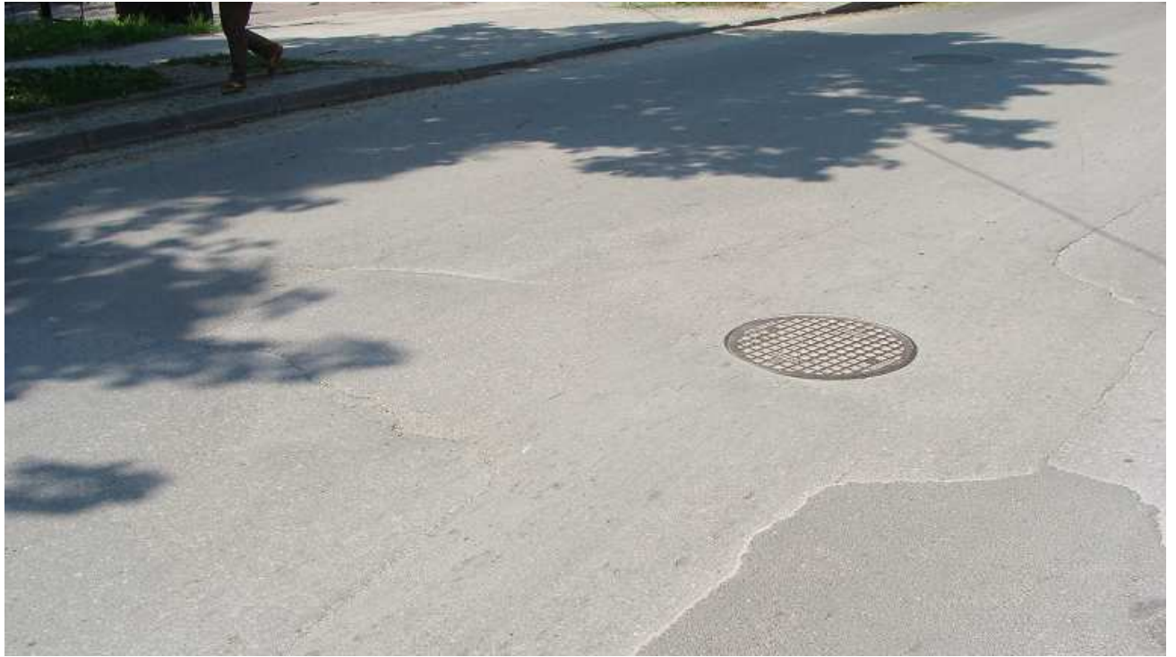
Fot. 10 Kanalizacja deszczowa na ul. Kościuszki w Busku - Zdroju
