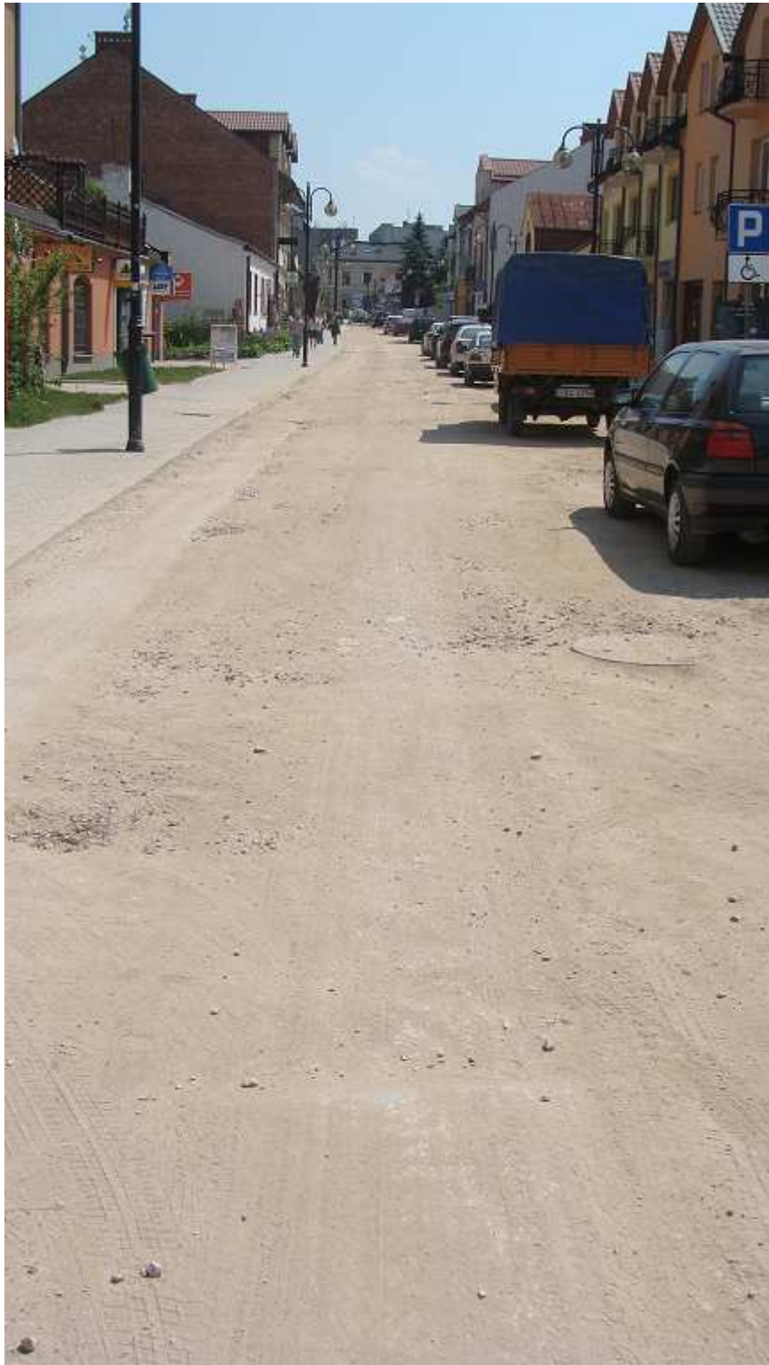
Fot. 14 Budowa kanalizacji deszczowej na ul. Kilińskiego w Busku - Zdroju
