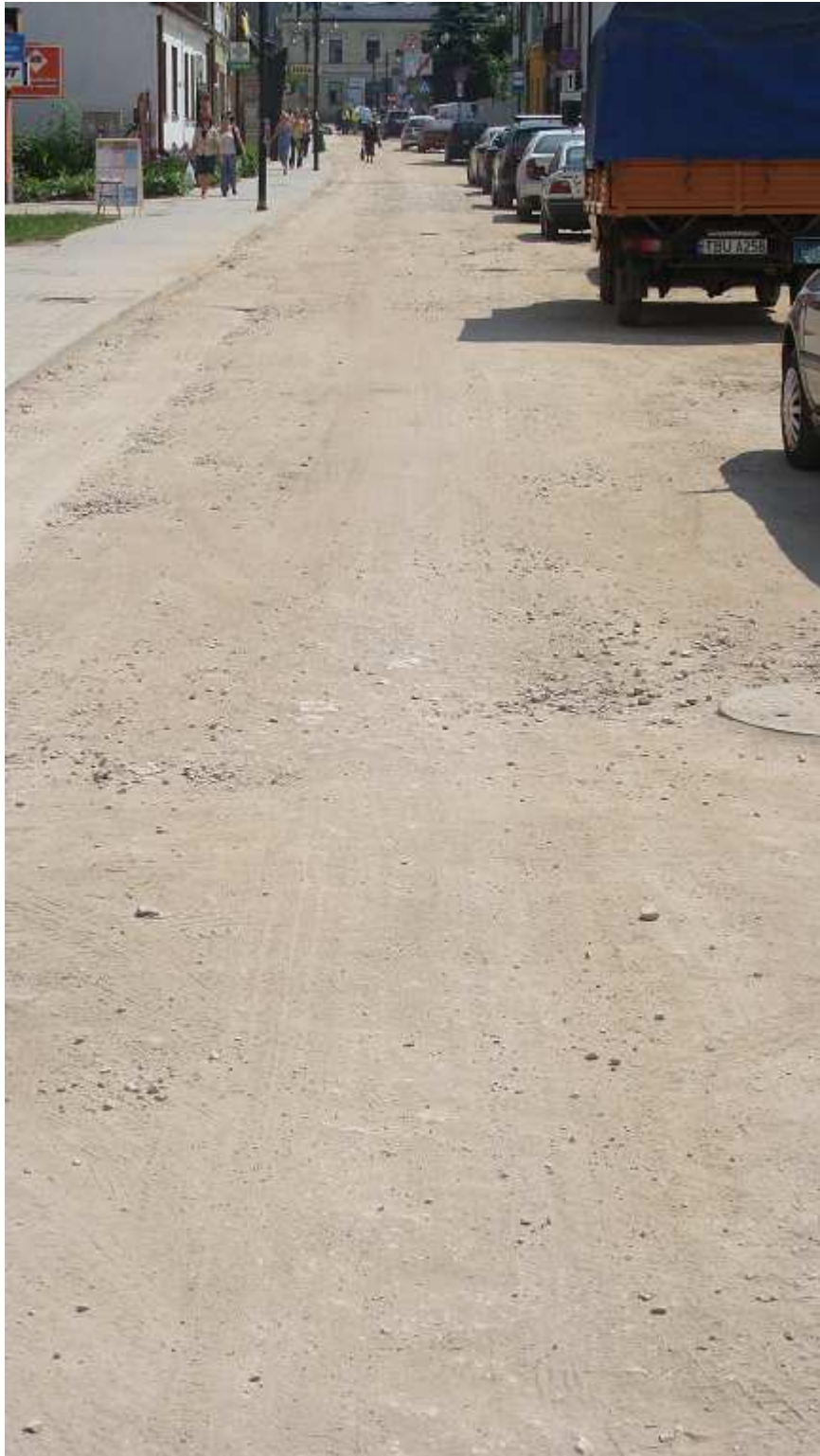
Fot. 15 Budowa kanalizacji deszczowej na ul. Kilińskiego w Busku - Zdroju
