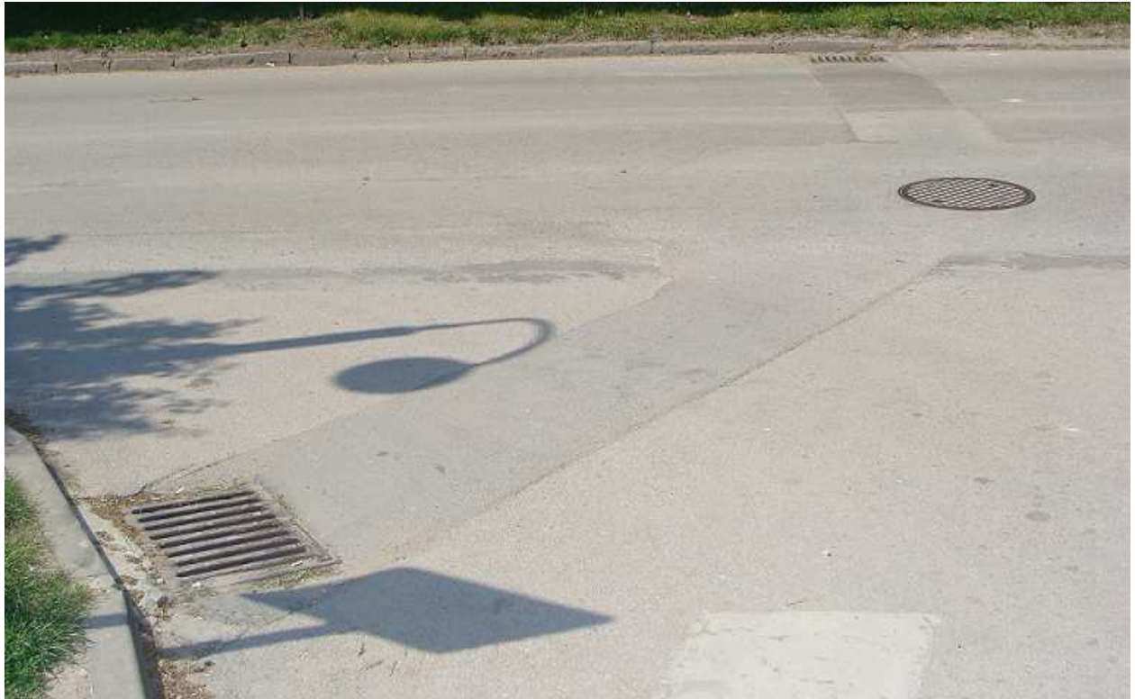
Fot. 6 Kanalizacja deszczowa na ul. Kopernika w Busku - Zdroju
