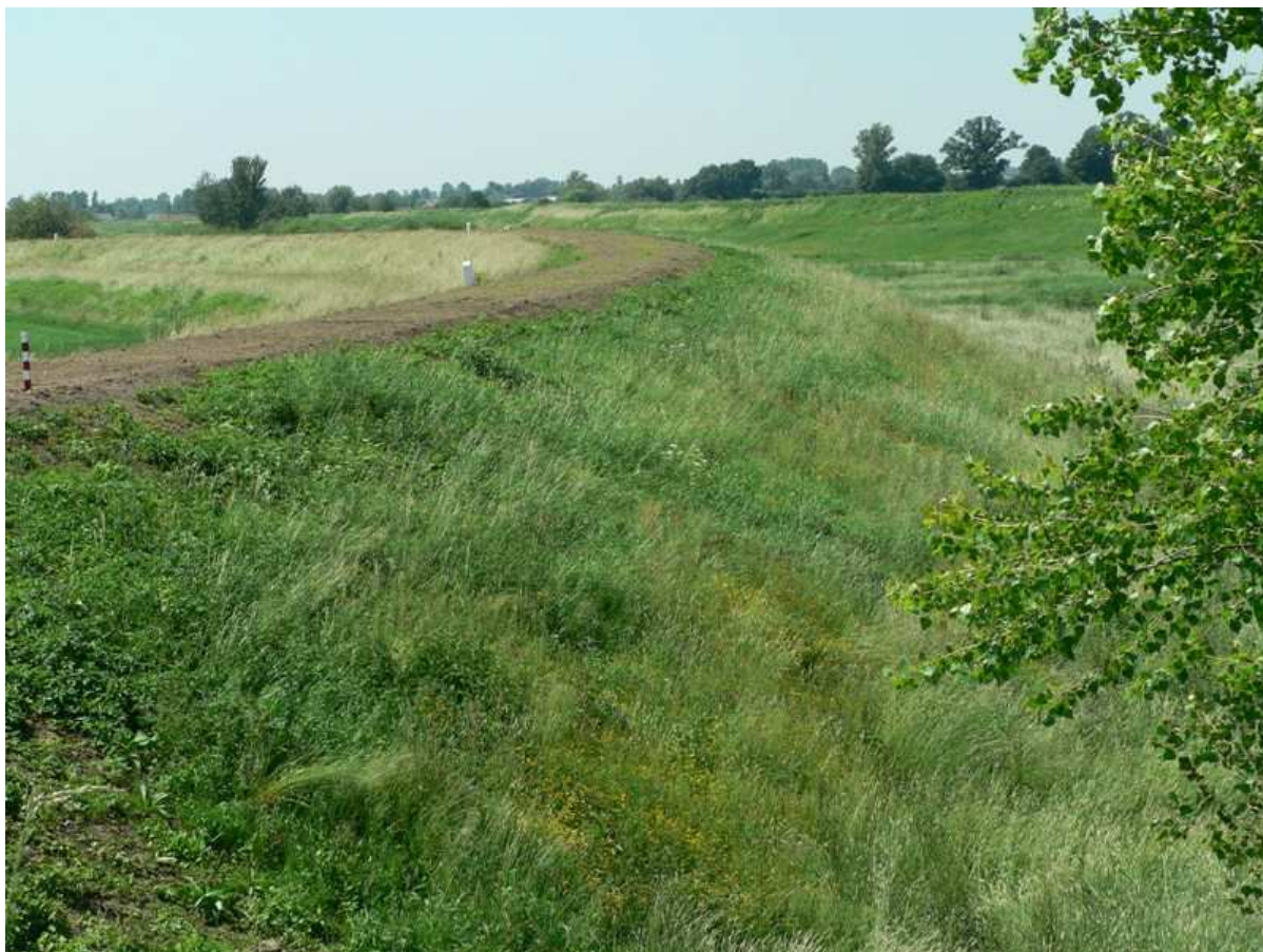
Rys. 2 Zabezpieczenia przeciwpowodziowego doliny Kanału Strumień w km 0+000 do km 12+980 zad.1 na terenie Gminy Łubnice i Połaniec pow. Staszów woj. Świętokrzyskie – korona wału obsiana mieszankami traw
