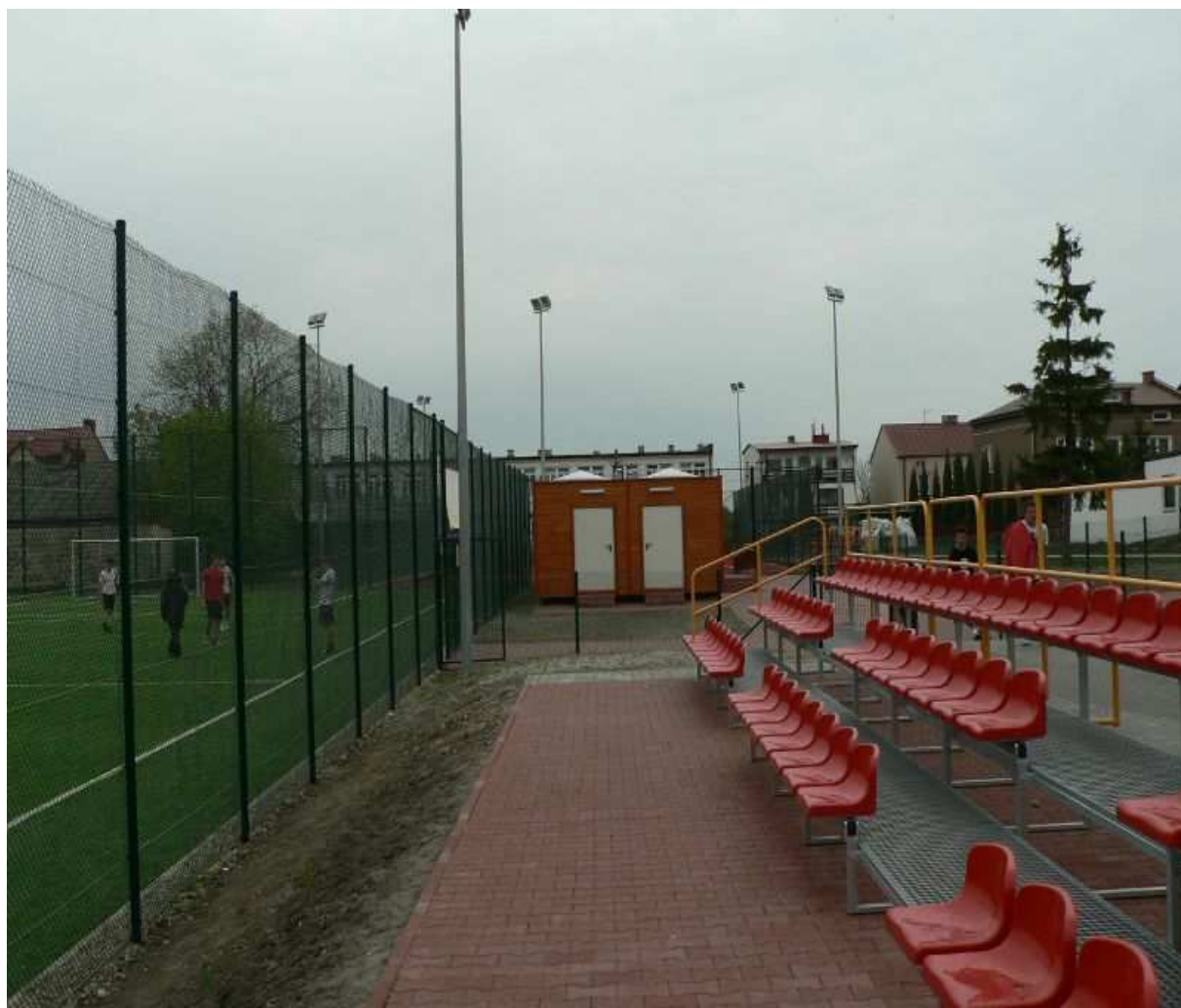
Zdj.1 Boisko wraz z trybunami. W tle Budynek szatniowo – sanitarny. Widoczne oświetlenie zewnętrzne boisk.
