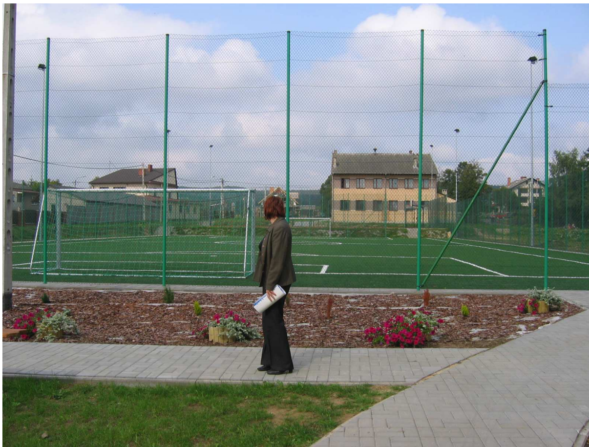
Zdj. 3 Ogrodzenie boiska wraz z piłkochwytyami
