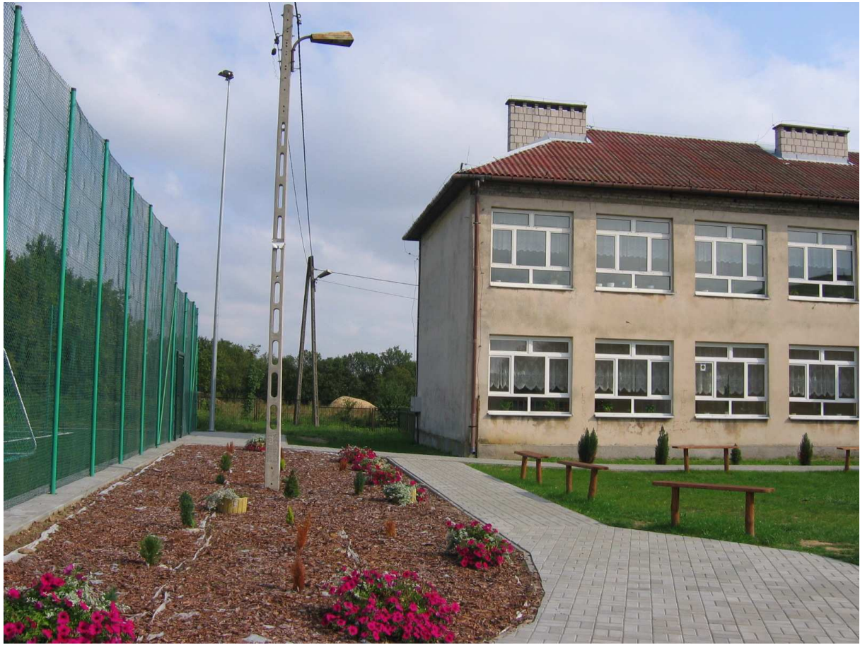
Zdj. 16 Ogrodzenie boiska
