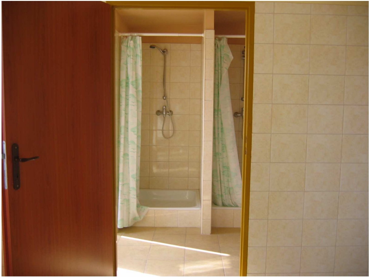
Zdj. 19 Wnętrze pomieszczenia higieniczno - sanitarnego
