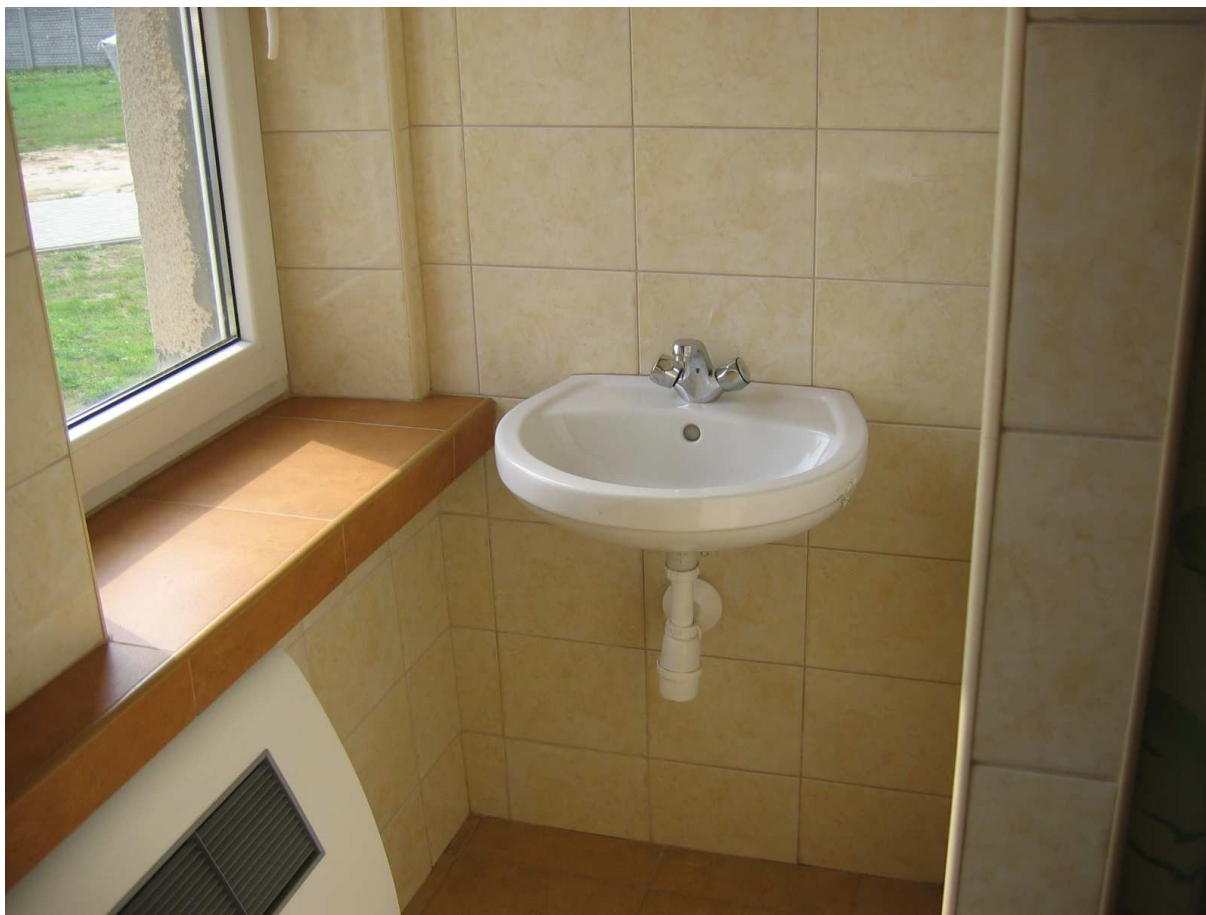
Zdj. 20 Wnętrze pomieszczenia higieniczno-sanitarnego
