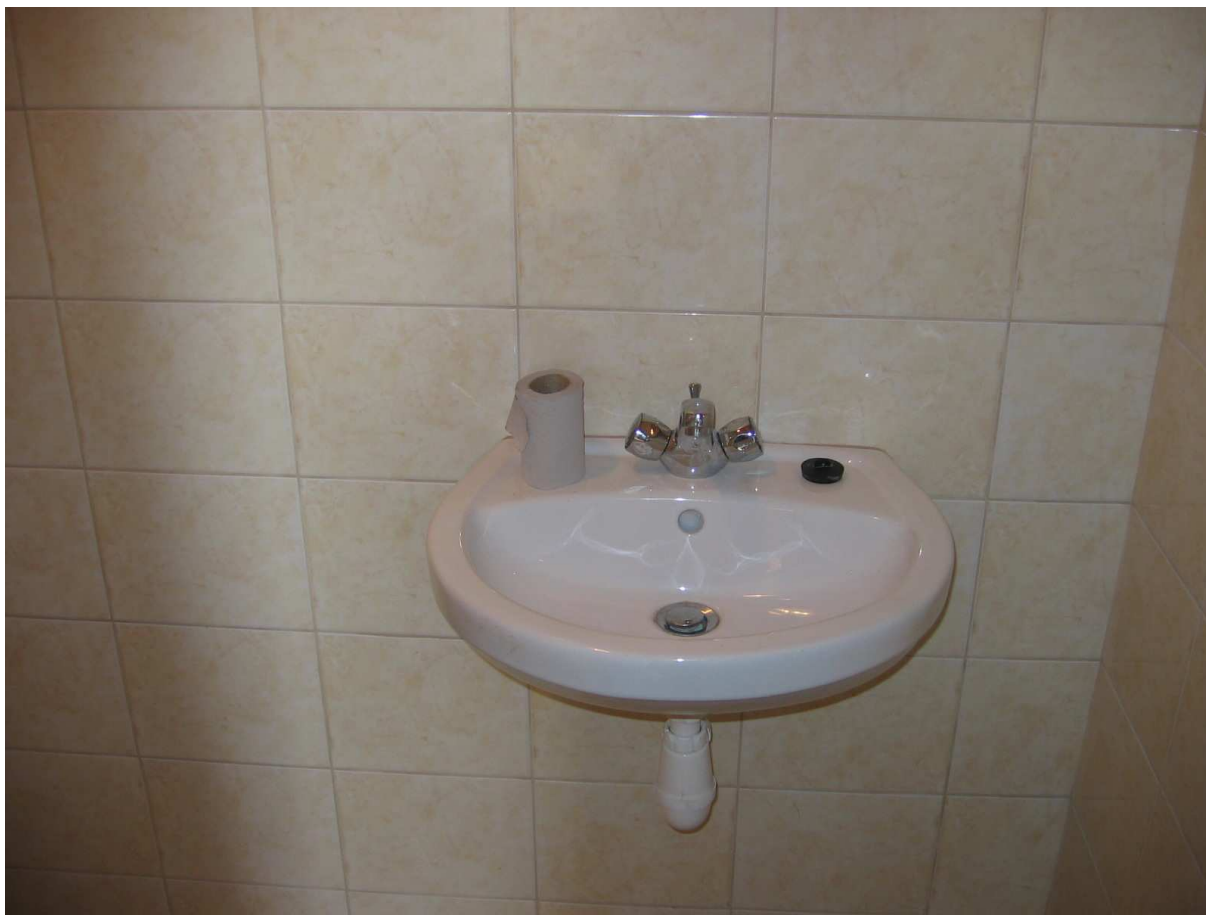
Zdj. 22 Wnętrze pomieszczenia higieniczno-sanitarnego
