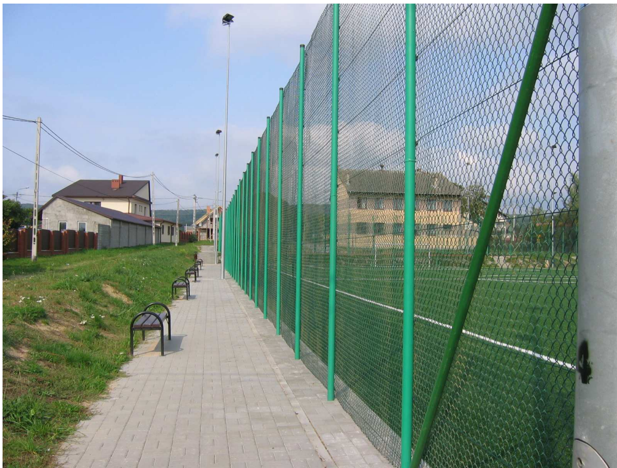
Zdj. 15 Ogrózenia boiska
