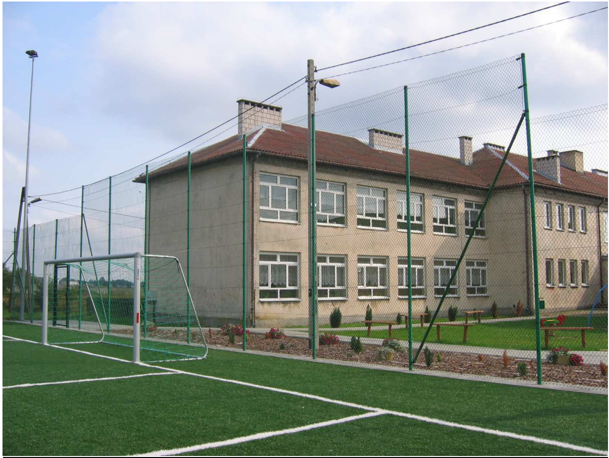
Zdj. 6 Ogrodzenie boiska
