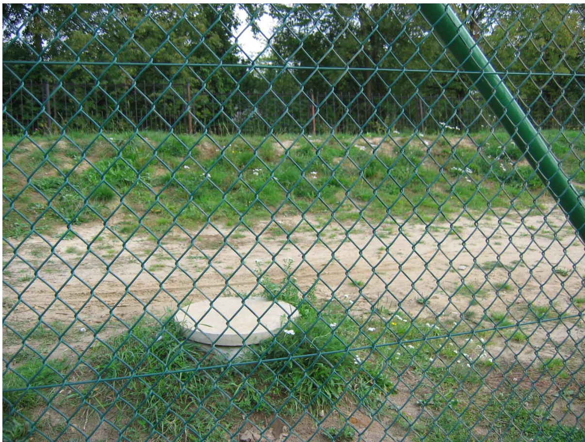
Zdj. 13 Odwodnienie boisk sportowych (studzienka) .
