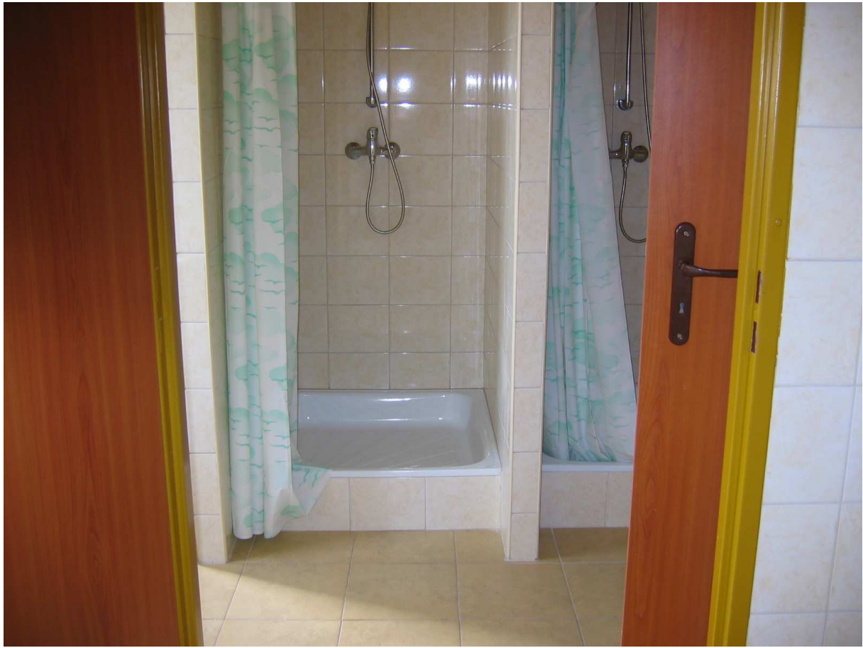
Zdj. 23 Wnętrze pomieszczenia higieniczno-sanitarnego
