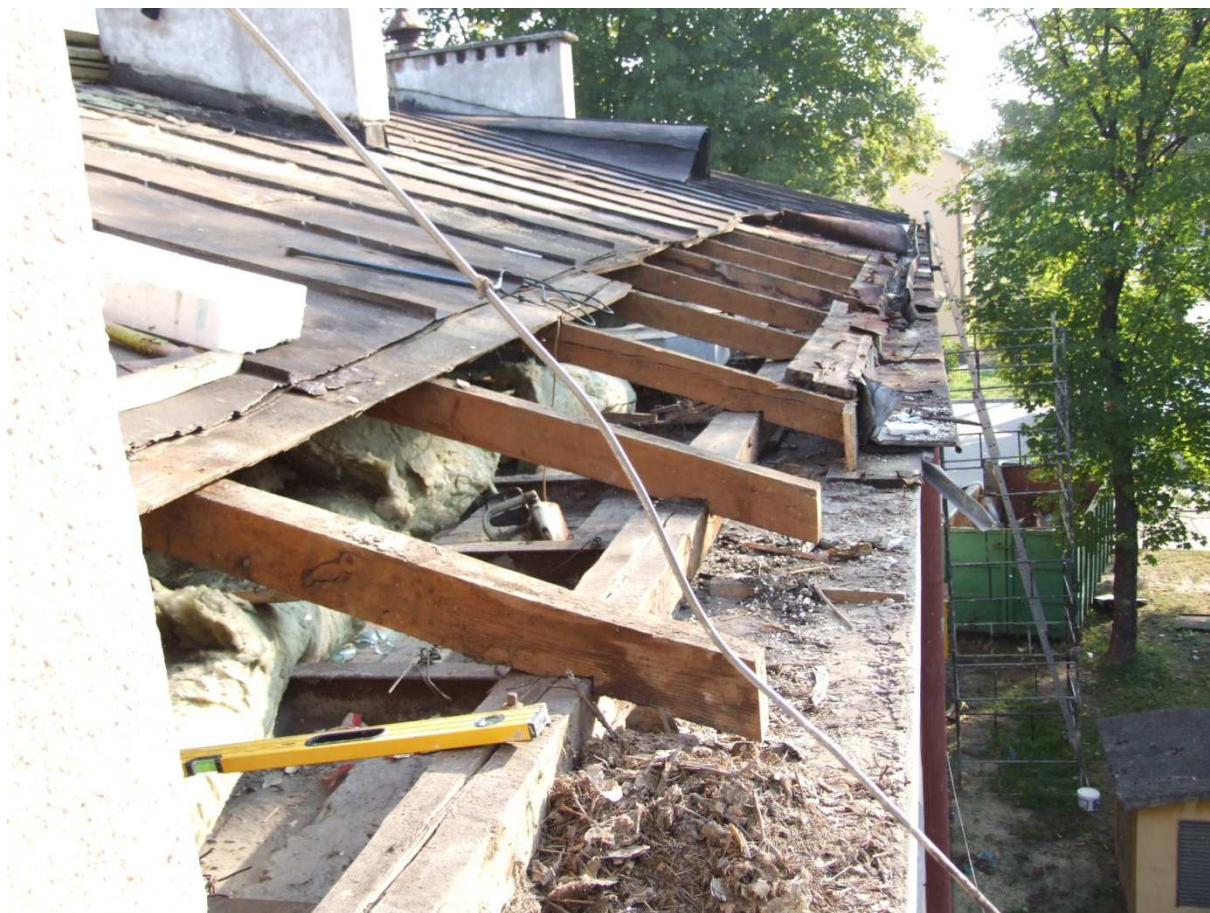
Zdjęcie (udostępnione przez Beneficjenta) wykonane w trakcie prac modernizacyjnych na zadaniu „Wymiana dachu na internacie I LO w Busku Zdroju”.
