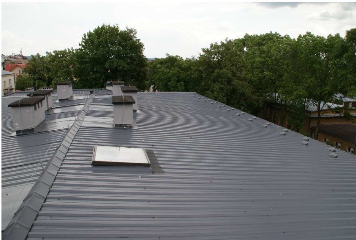
„Wymiana dachu na internacie I LO w Busku Zdroju”
