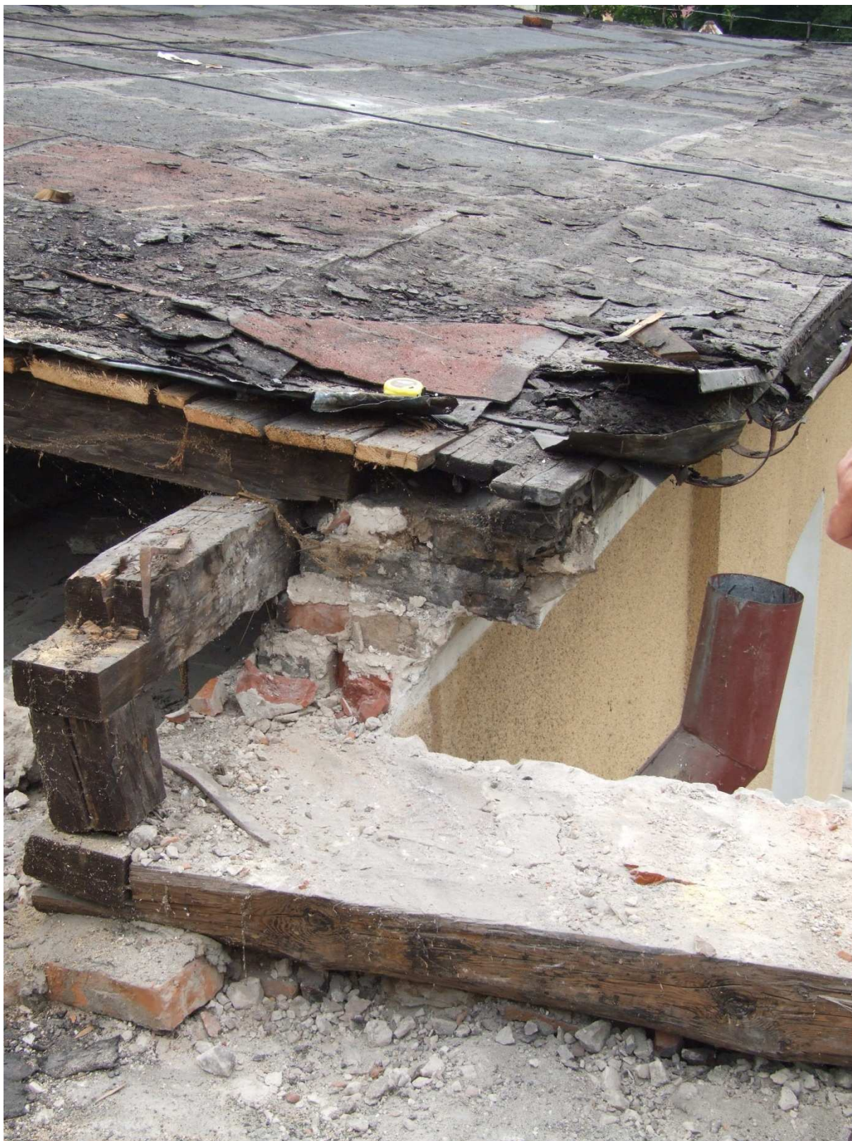
Zdjęcie (udostępnione przez Beneficjenta) wykonane w trakcie prac modernizacyjnych na zadaniu „Wymiana dachu na internacie I LO w Busku Zdroju”.
